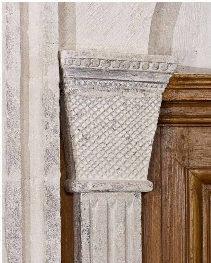
Premier chapiteau gauche de l'abside.
