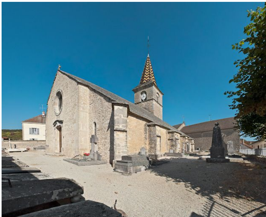
Façade et élévation droite.
