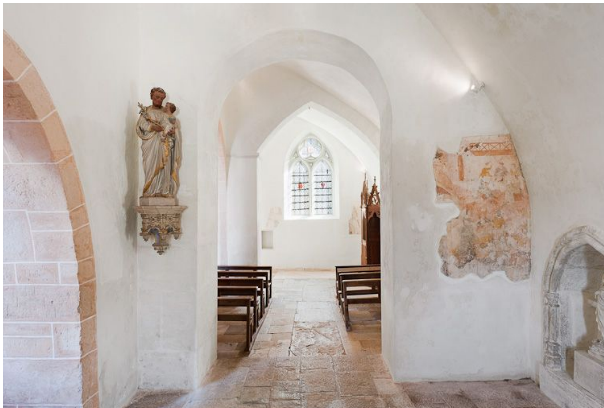
Bas-côté droit pris depuis la première travée. 21, Monthelie rue de l' Escalier
