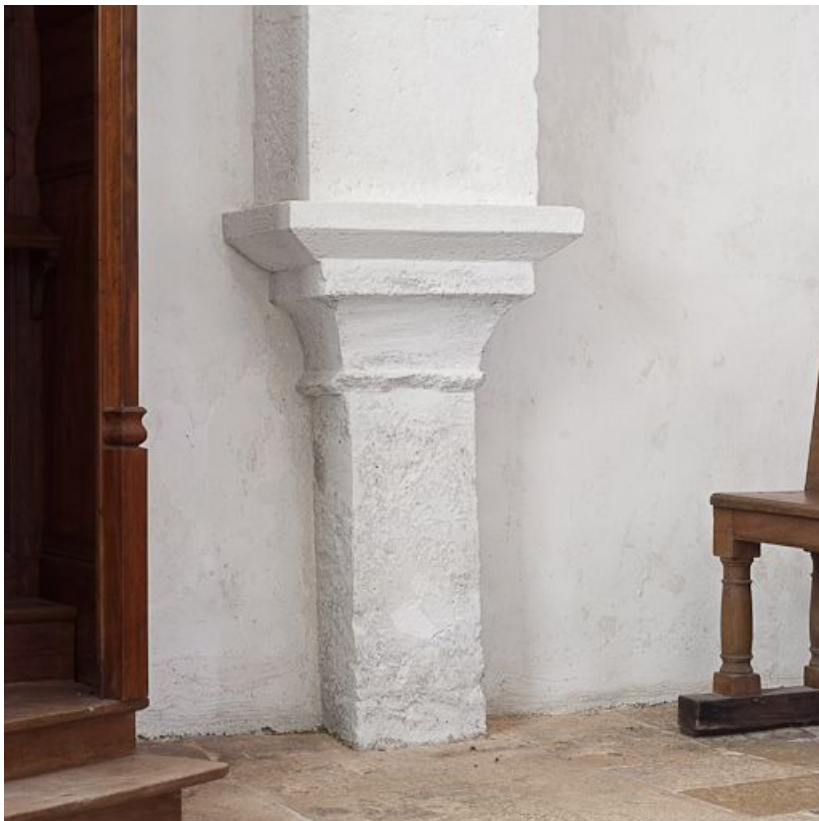
Bas-côté droit, pilier de l'arc antérieur de la dernière travée. 21, Monthelie rue de l' Escalier
