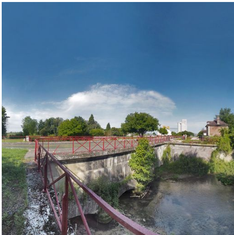
Vue d'ensemble. La maison éclésièrre est à droite.
