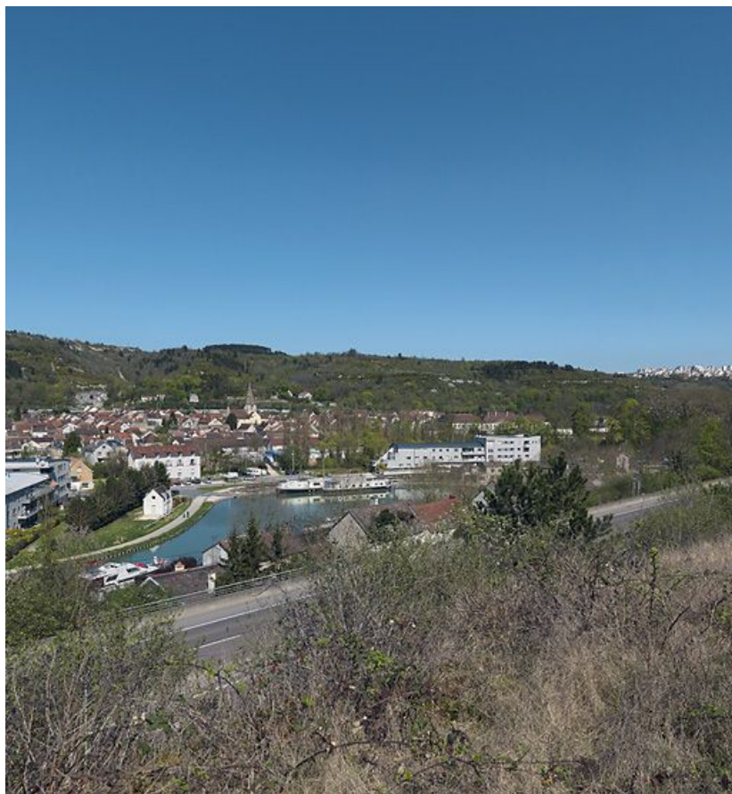
Vue d'ensemble du port de Plombières-lès-Dijon.
