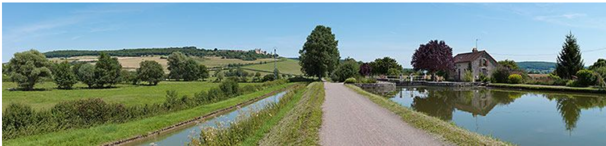
Vue d'ensemble prise d'amont. La rigole longe le canal à gauche. Château de Châteauneuf en arrière-plan. 21, Vandenesse-en-Auxois, lieu-dit : bief 09 du versant Saône
