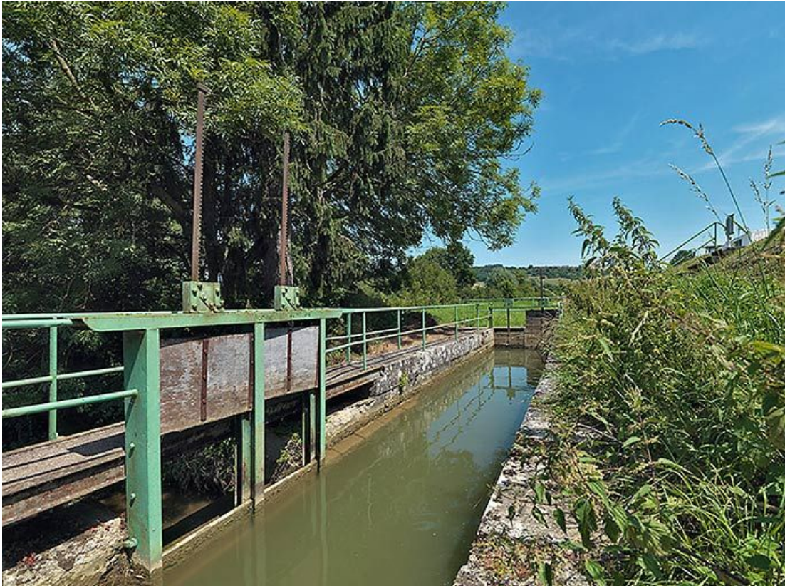
Vannes de régulation sur la rigole.
