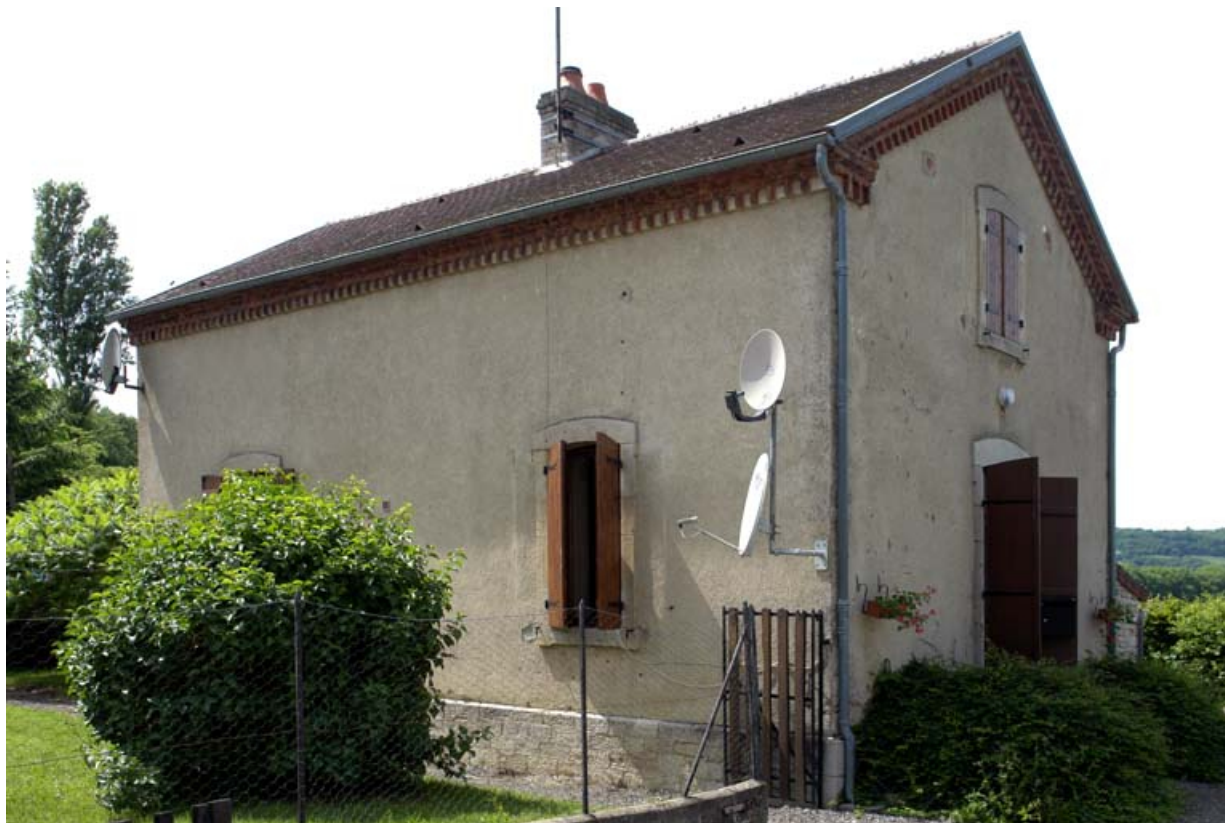
Maison de garde, élévations latérale gauche et principale, vues de trois-quarts.
