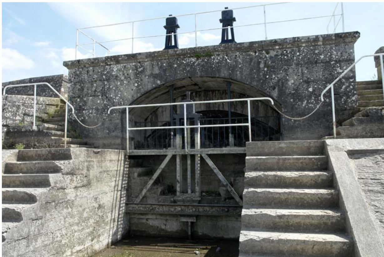
Digue est, ouvrage avec vannes en sortie du réservoir.
