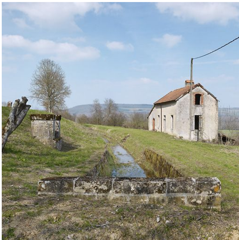
Vue d'ensemble de la maison de garde avec au centre la rigole et à gauche, le puits. On aperçoit la borne à l'extrême gauche. 21, Éguilly, lieudit : Eguilly
