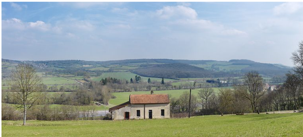
Vue de face de la maison avec en arrière-plan le paysage du canal de Bourgogne. A droite, on distingue le château d'Eguilly. 21, Éguilly, lieudit : Eguilly
