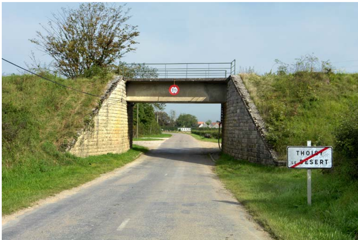
Rigole d'alimentation de Cercey ; passage supérieur, vue de la route D.108. 21, Thoisy-le-Désert, lieudit : Cercey
