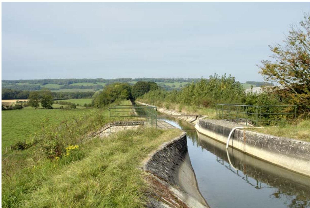
Rigole d'alimentation de Cercey ; passage supérieur, vue des berges de la rigole.
