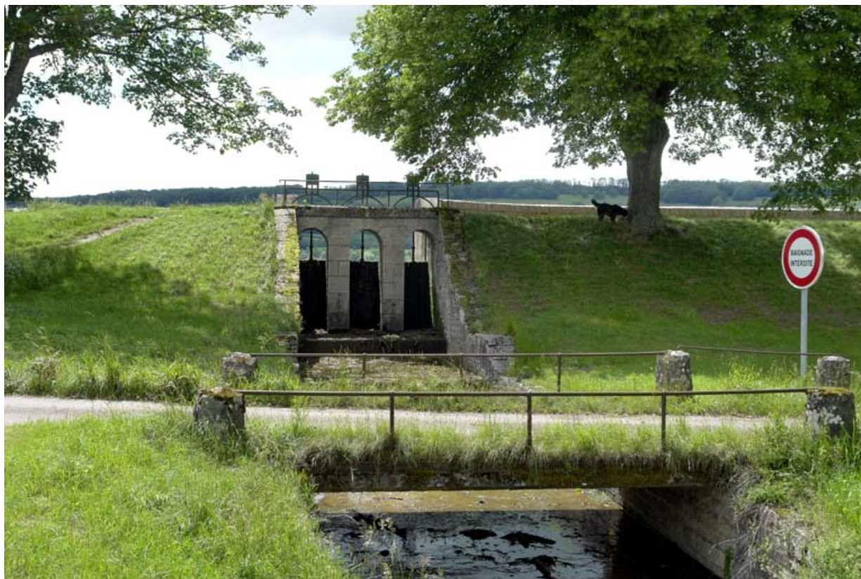
Déversoir ou "évacuateur de crue" à l'extrémité droite de la digue principale, commandé par trois vannes. 21, Thoisy-le-Désert, lieudit : Cercey
