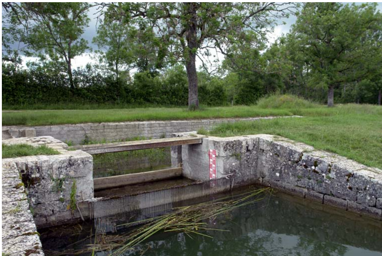
Rigole de prise d'eau de Thorey ; arrivée dans le réservoir.
