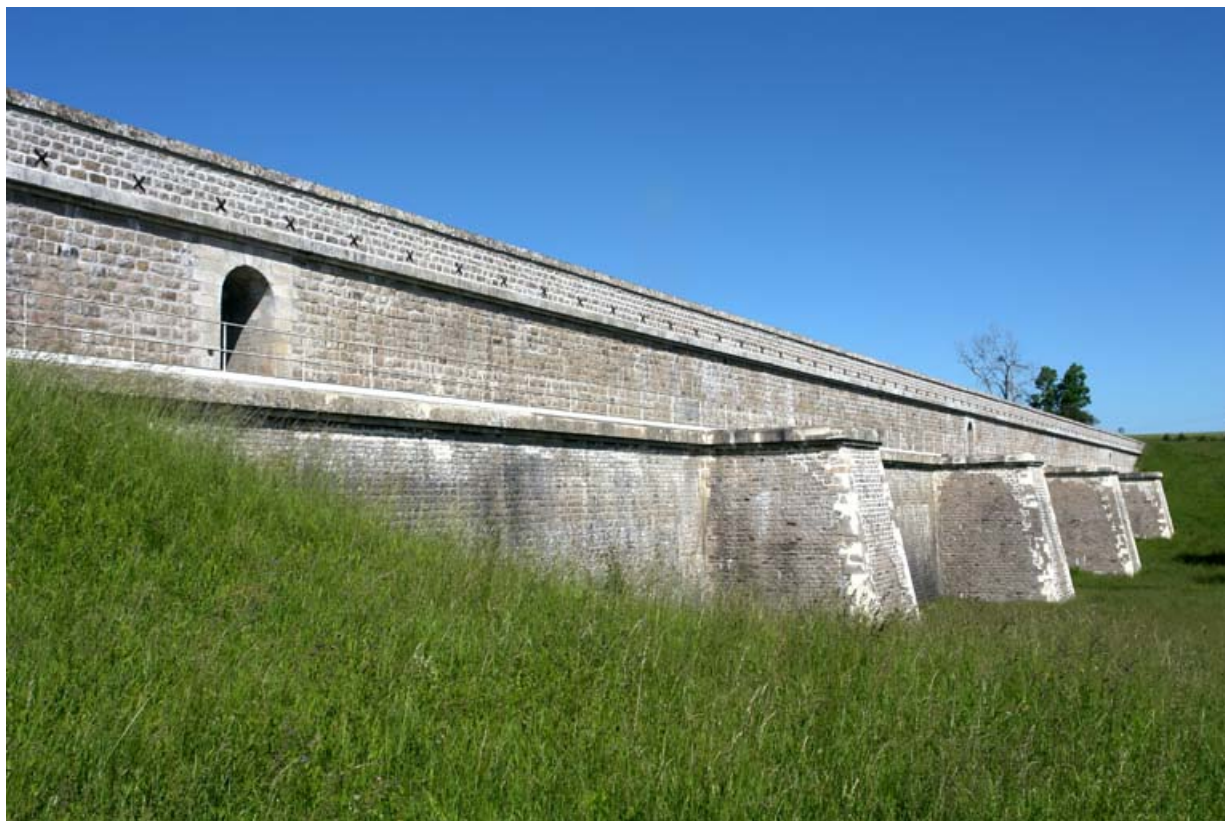
Face avant du barrage, vue d'ensemble.
