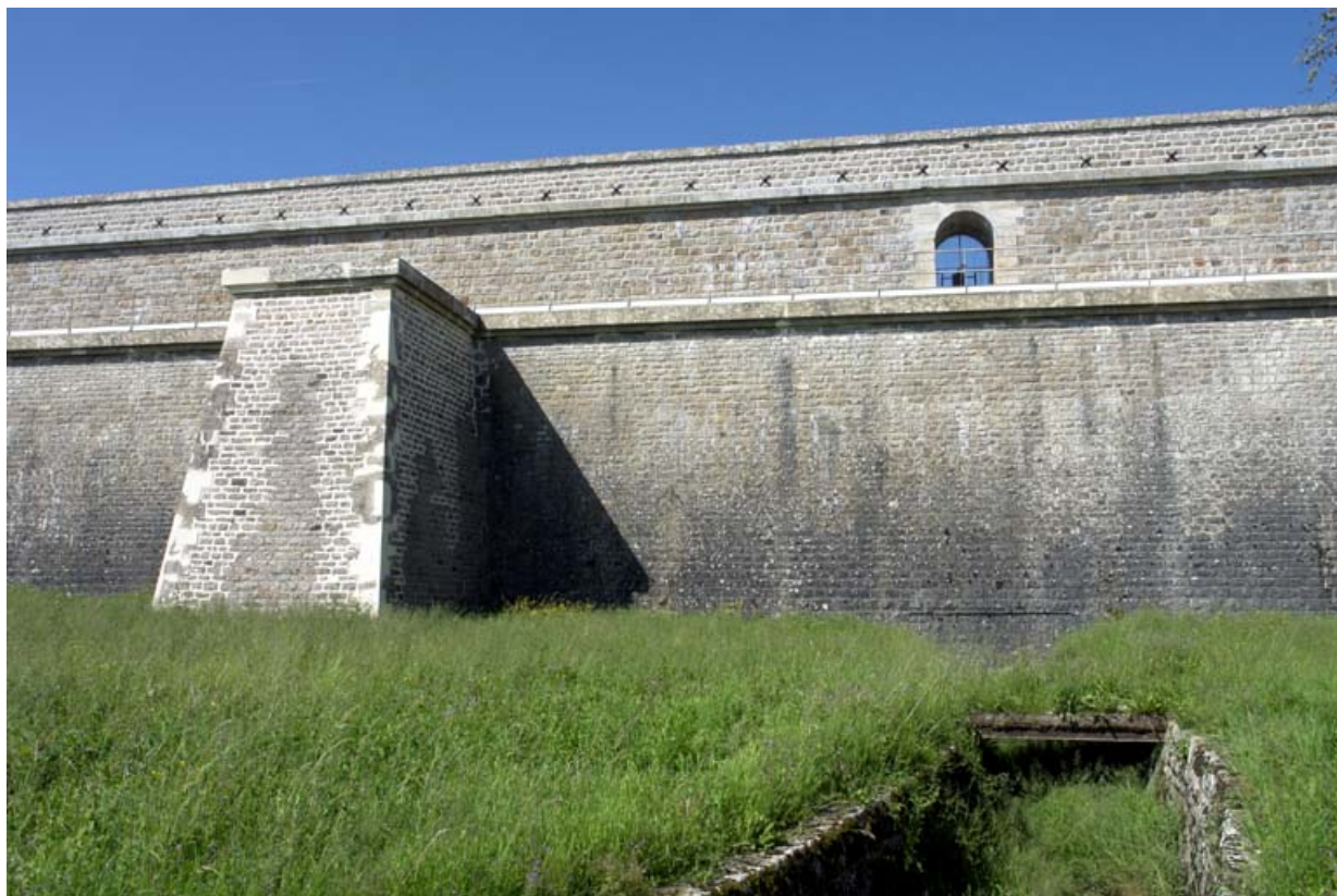
Face avant du barrage, au premier plan la rigole de la vanne de vidange.
