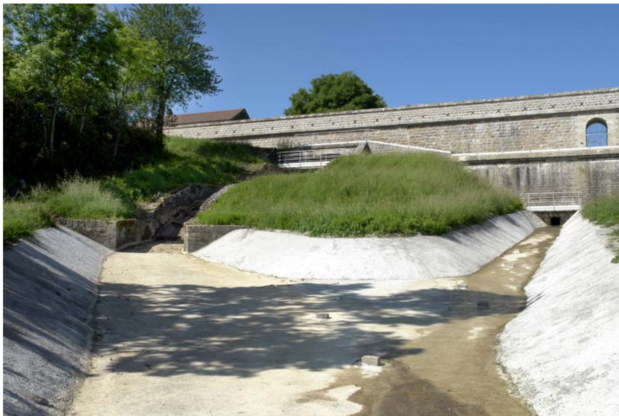
Rigole de décharge du déservoir de superficie qui rejoint celle de la tour de prise d'eau et de la vanne de fond. 21, Rouvres-sous-Meilly, lieudit : le Tillot
