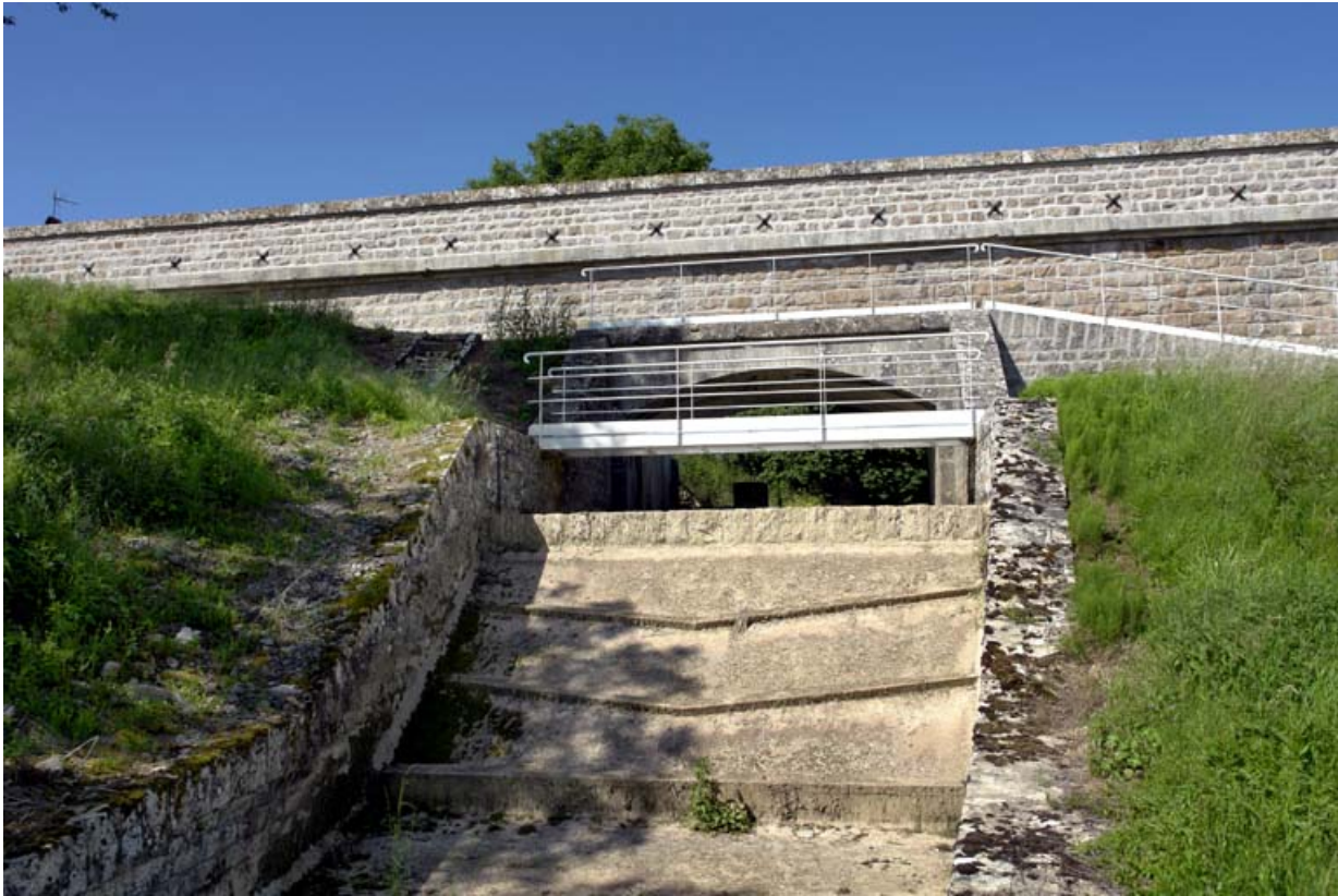
Déversoir de surface du réservoir, prolongé par une chute d'eau en trois paliers et surmonté d'une passerelle. 21, Rouvres-sous-Meilly, lieudit : le Tillot
