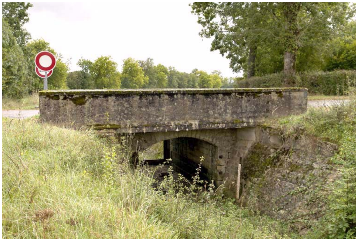
Pont routier sur la rigole de prise d'eau dite "rigole de Beaume", vue aval. 21, Chazilly, lieudit : Chazilly
