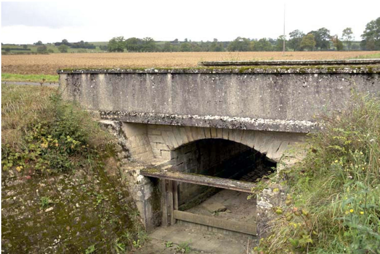
Pont routier sur la rigole de prise d'eau dite "rigole de Beaume", vue amont. 21, Chazilly, lieudit : Chazilly
