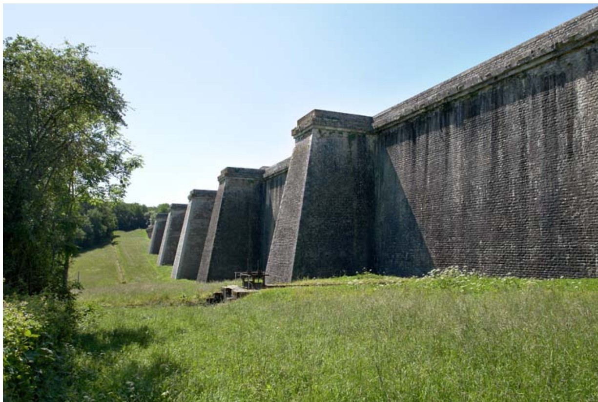
Face avant du barrage, vue de l'extrémité nord. La rigole d'alimentation au premier plan.
