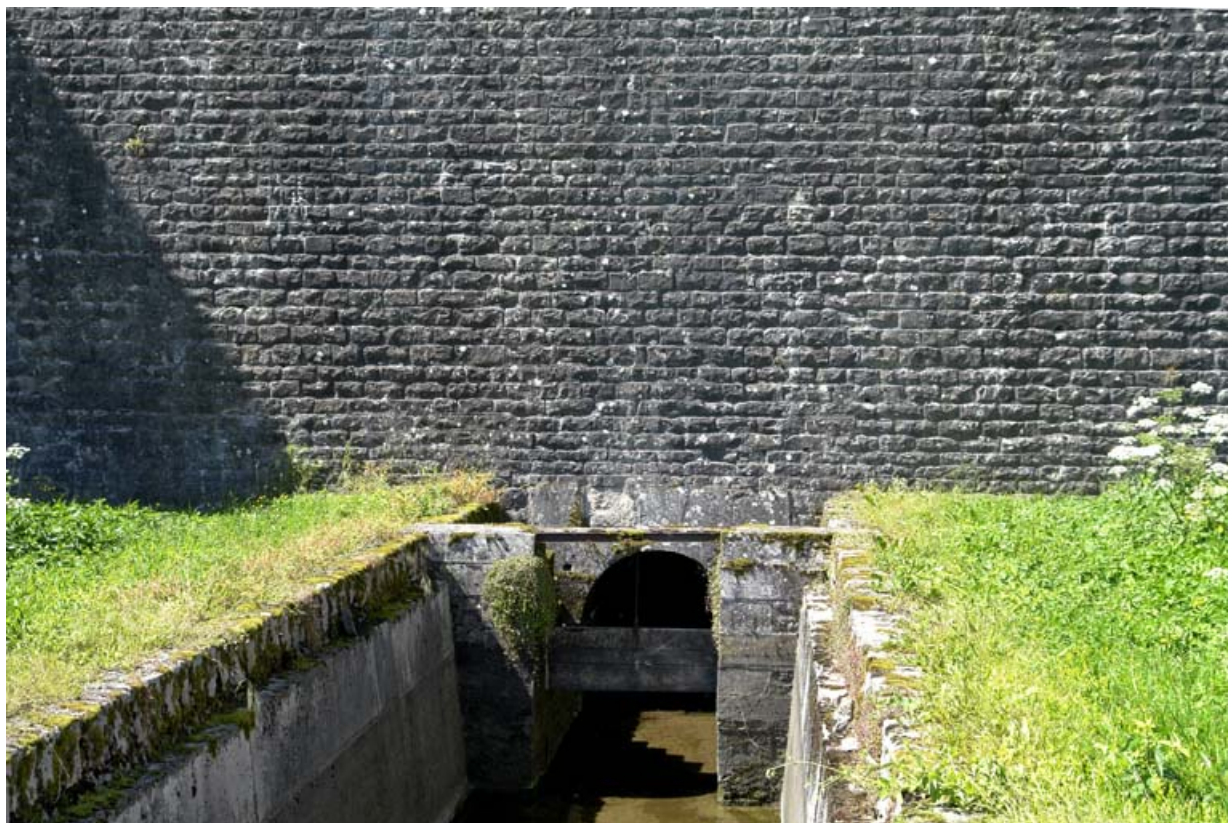
Sortie d'eau au pied du barrage pour la rigole d'alimentation du canal.
