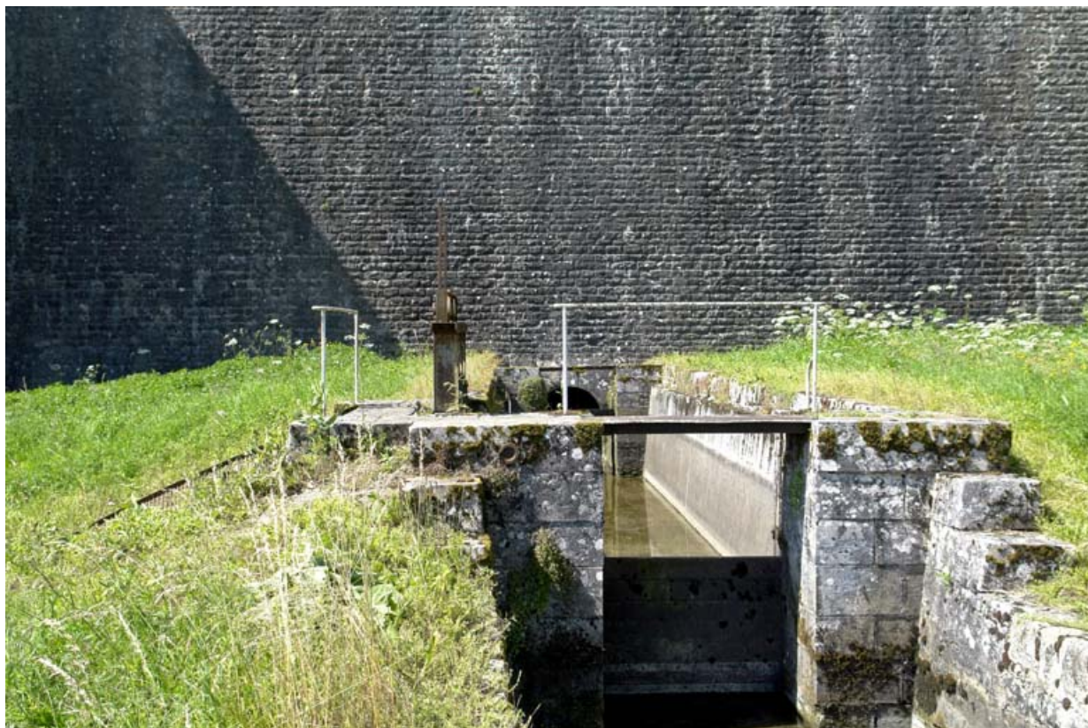
Sortie d'eau au pied du barrage et départ de la rigole d'alimentation du canal. 21, Chazilly, lieudit : Chazilly
