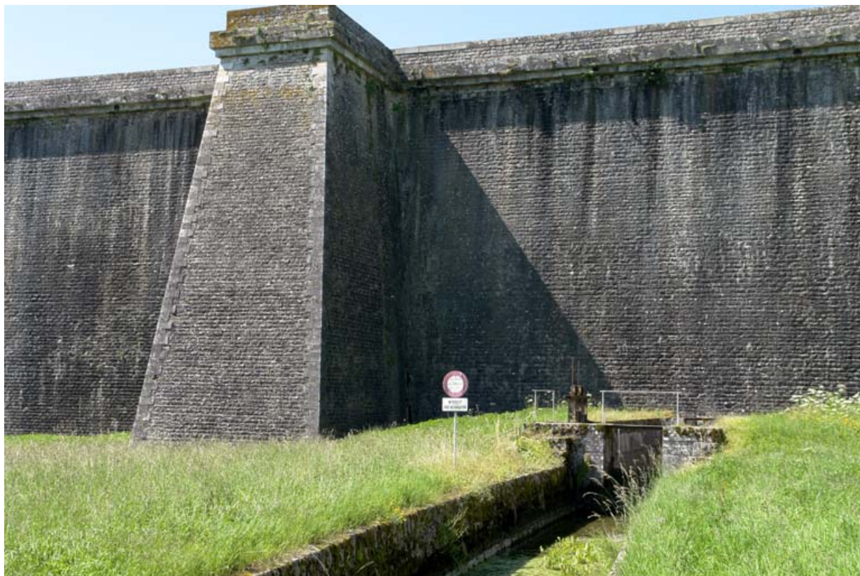
Face avant du barrage avec un contrefort et la rigole d'alimentation du canal. 21, Chazilly, lieudit : Chazilly
