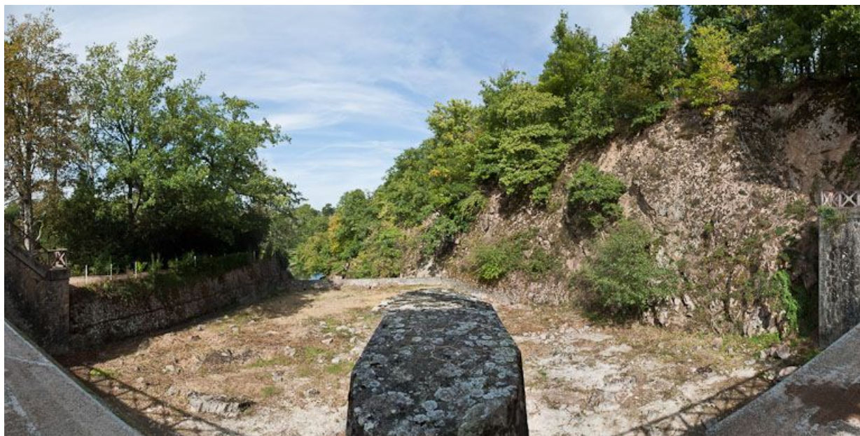
Vue de la rigole de décharge du déversoir.
