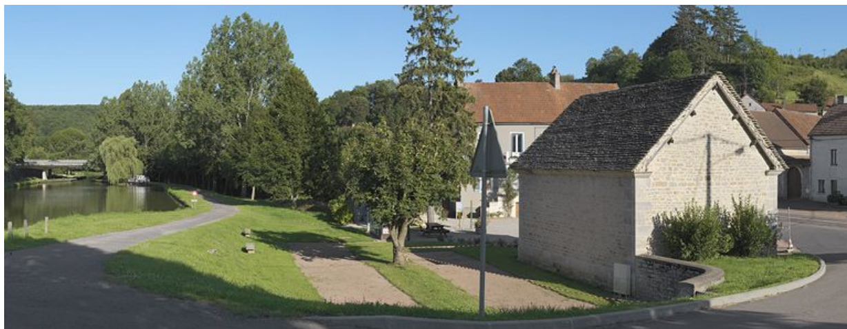
Le lavoir de Crugey ; le port de Crugey. Viaduc en arrière-plan.
