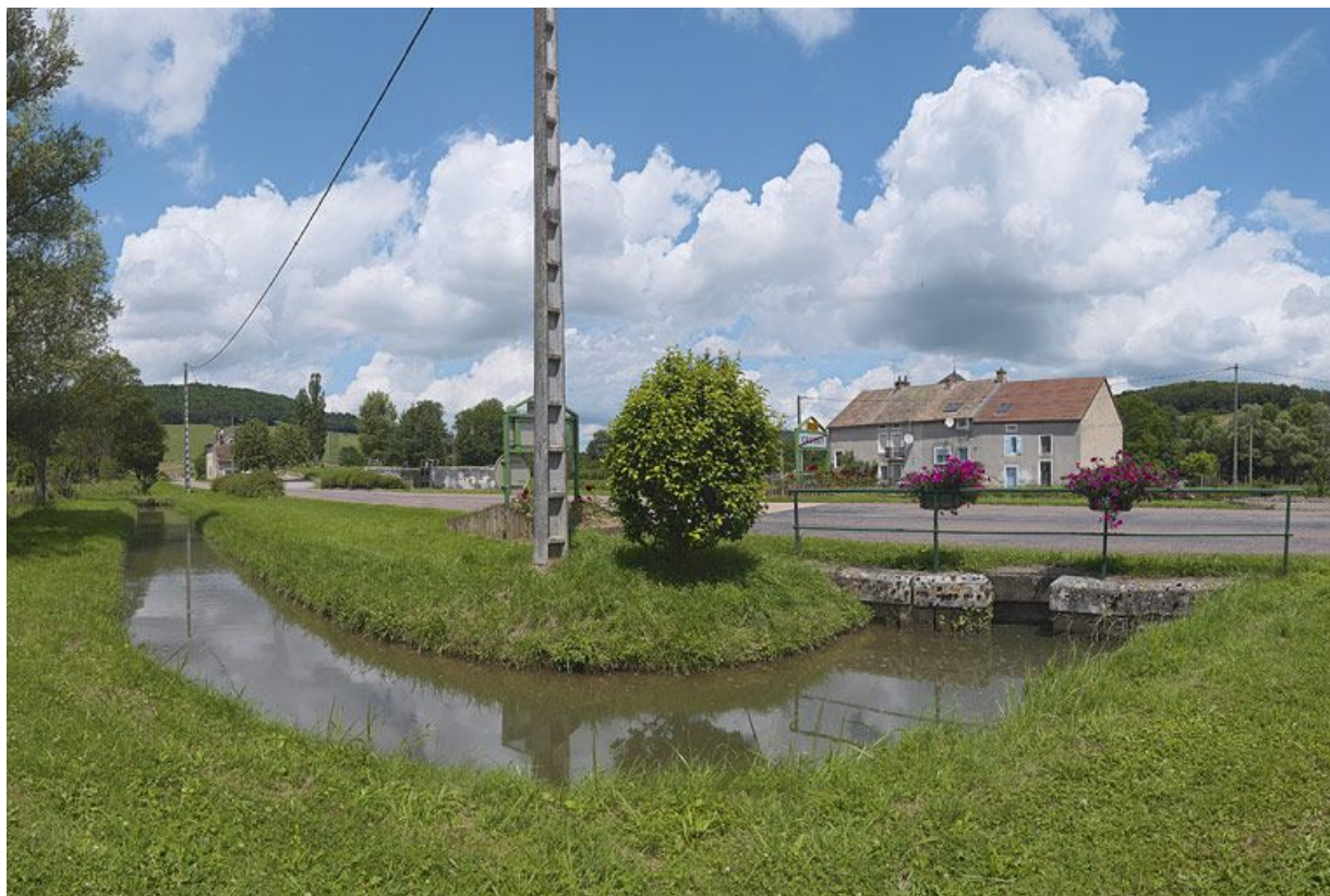
La rigole d'alimentation rive droite en aval du site d'écluse 16.
