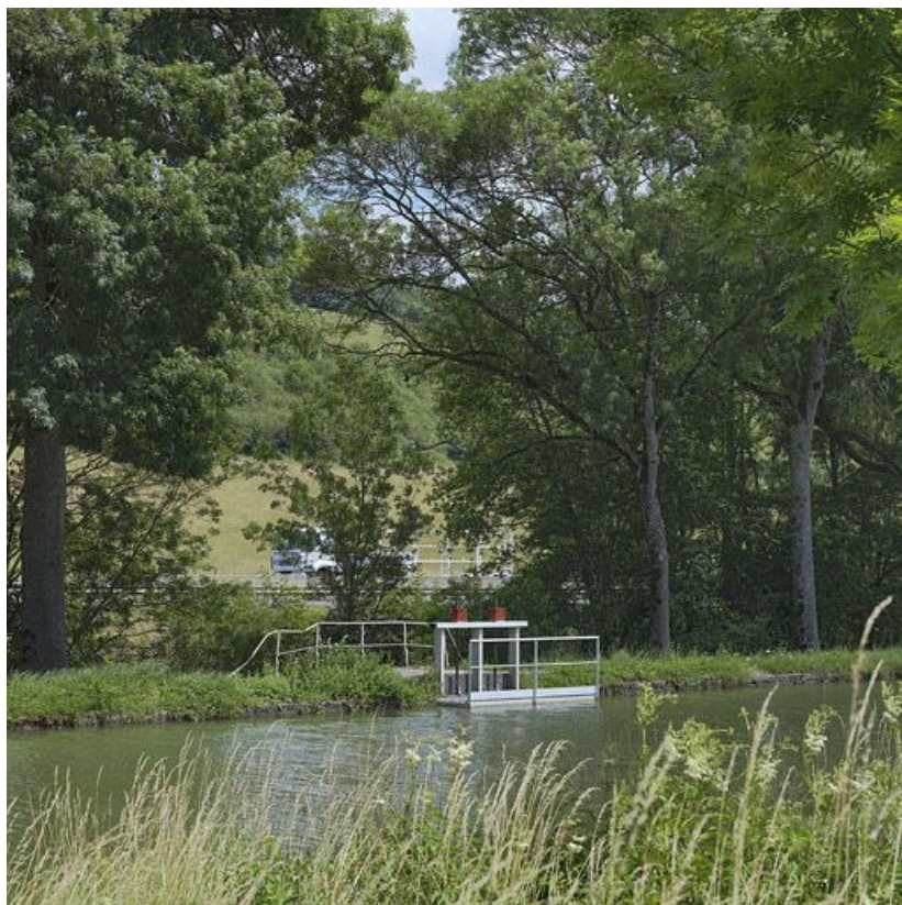
Vannes et garde-corps du déversoir vus de la rive droite. Autoroute en arrière-plan.
