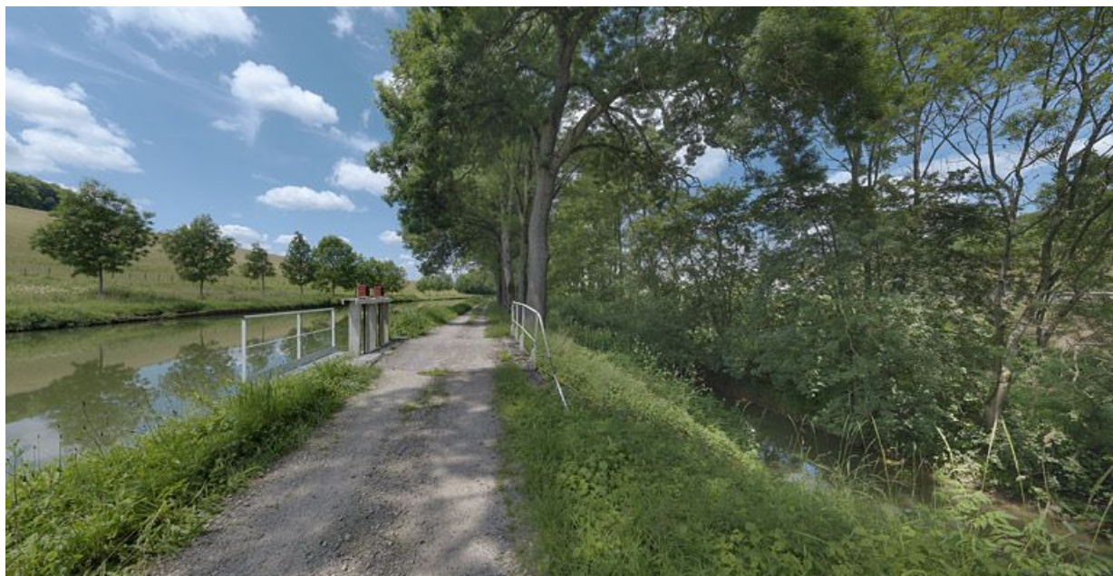
Vannes et garde-corps du déversoir vus du chemin de halage, en aval.
