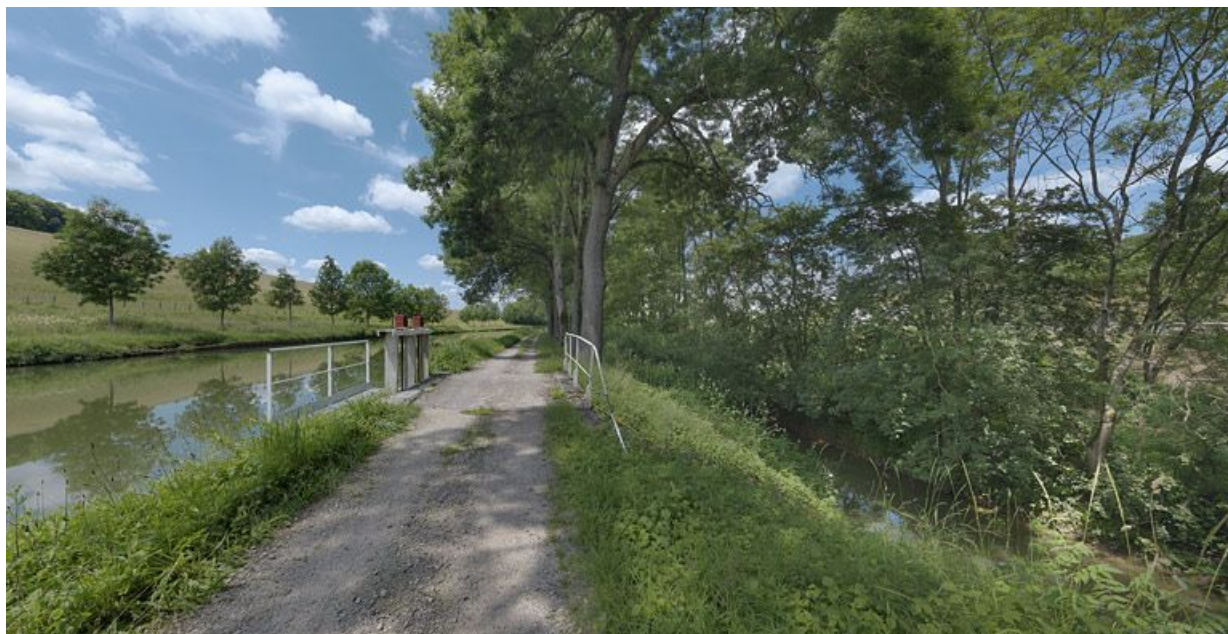
Vannes et garde-corps du déversoir vus du chemin de halage, en aval.
