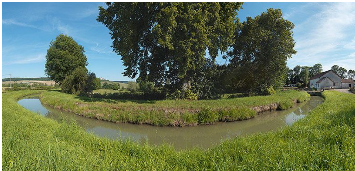
Vue de la rigole à son arrivée vers le canal.
