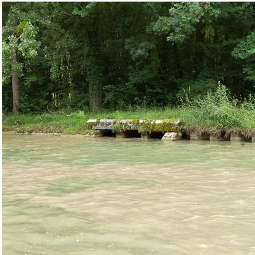
Vue du ponceau sur la rive droite du canal.
