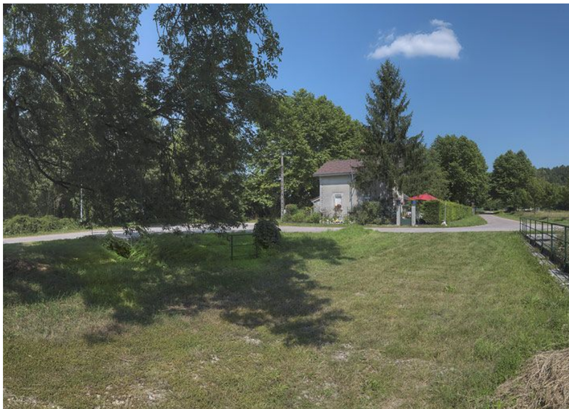
L'ancienne maison de garde-barrière dans son site. On distingue à droite le garde-corps de la rigole d'alimentation. 21, Gisse-sur-Ouche, lieudit : bief 33 du versant Saône
