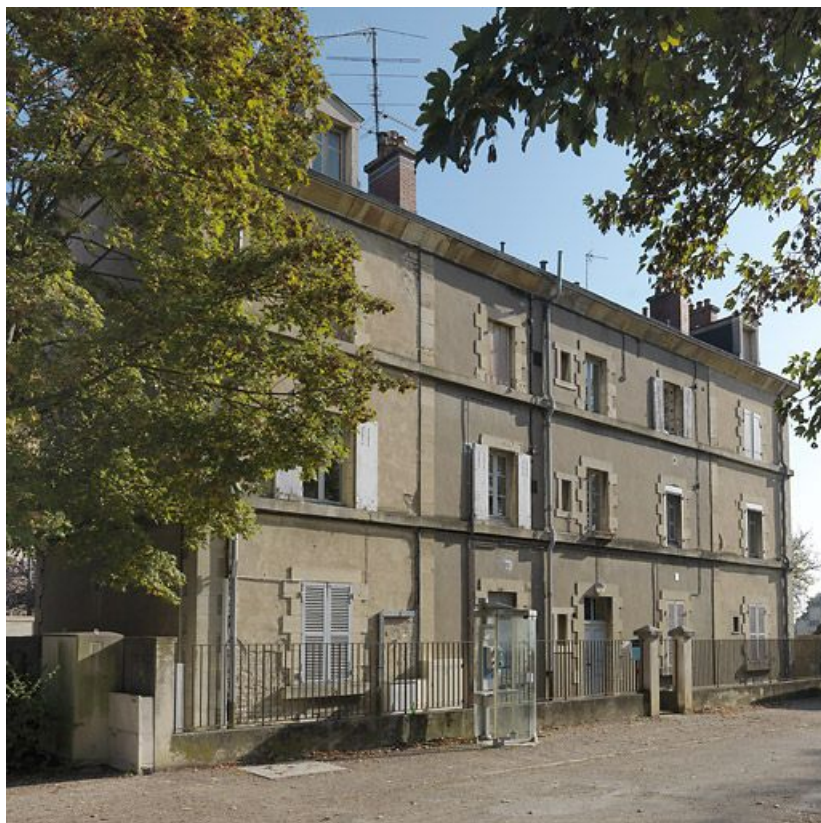
Façade sur port de la maison de perception de Dijon.
