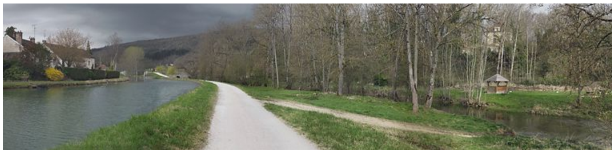
A Gissey-sur-Ouche, le château surplombe le canal à droite à travers les arbres. Au fond, le pont sur canal à gauche et le pont en pierre sur l'Ouche à droite.
