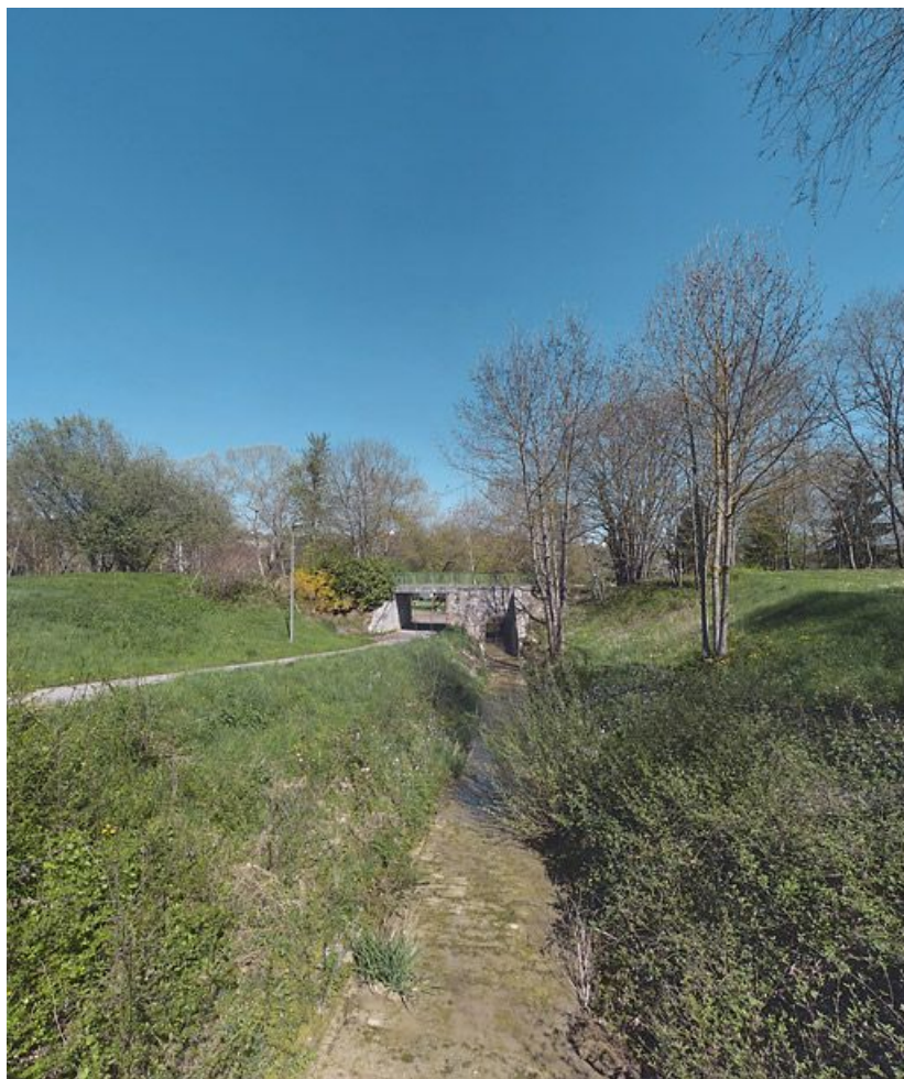
Déversoir du canal dans l'Ouche : rigole menant au pont de l'ancienne voie de chemin de fer Dijon-Epinac devenu piéton. L'ensemble fait aujourd'hui partie du parc entourant le lac Kir.
