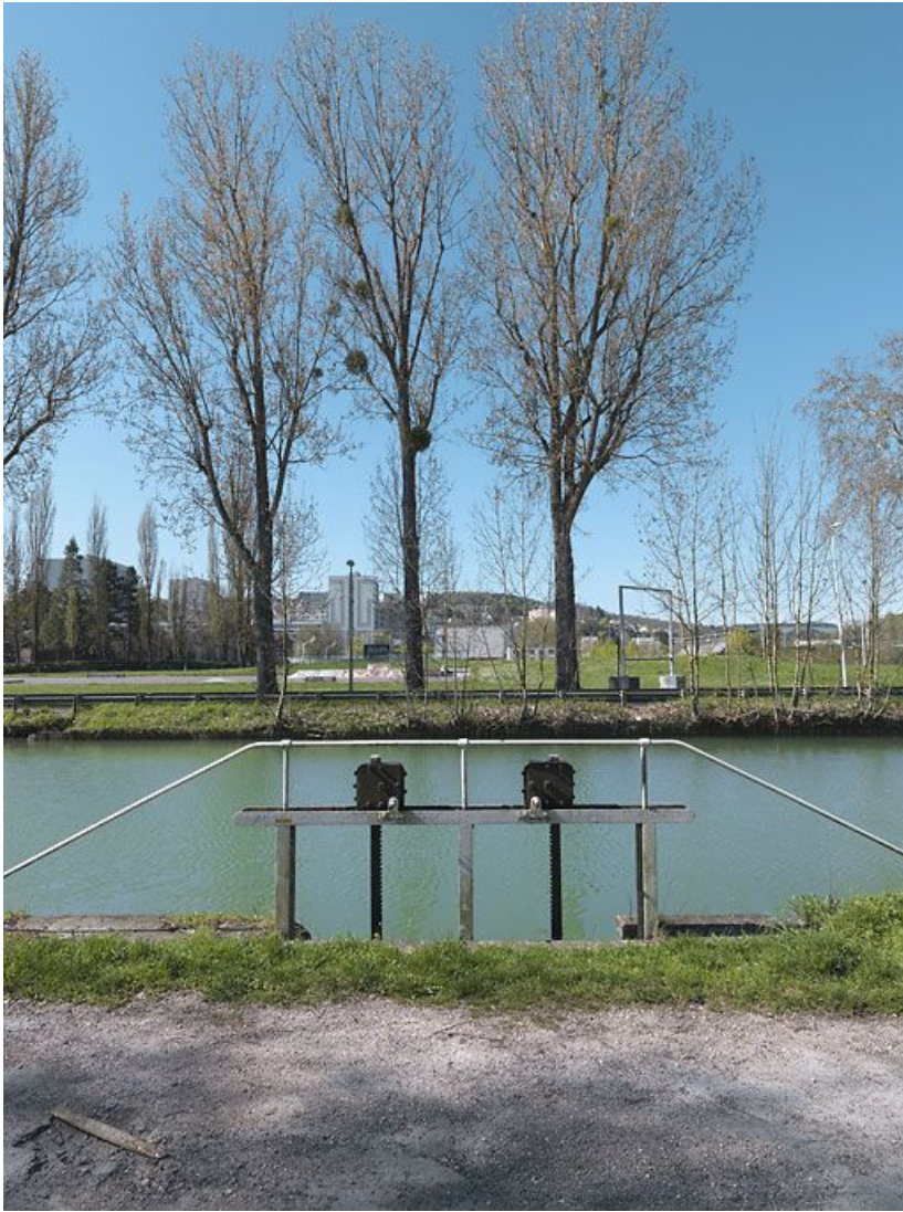
Déversoir du canal dans l'Ouche : vannes.
