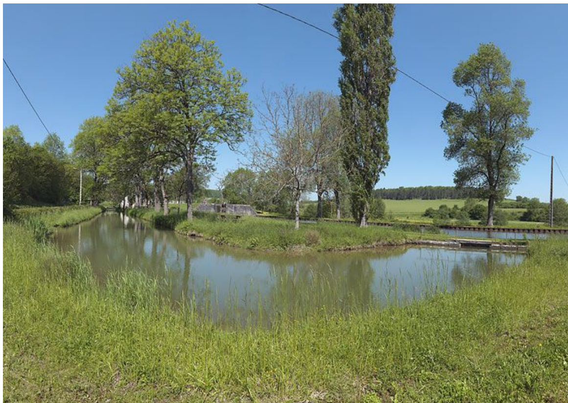
Arrivée de la rigole d'alimentation en aval du bief 20. 21, Veuve-sur-Ouche, lieudit : bief 20 du versant Saône
