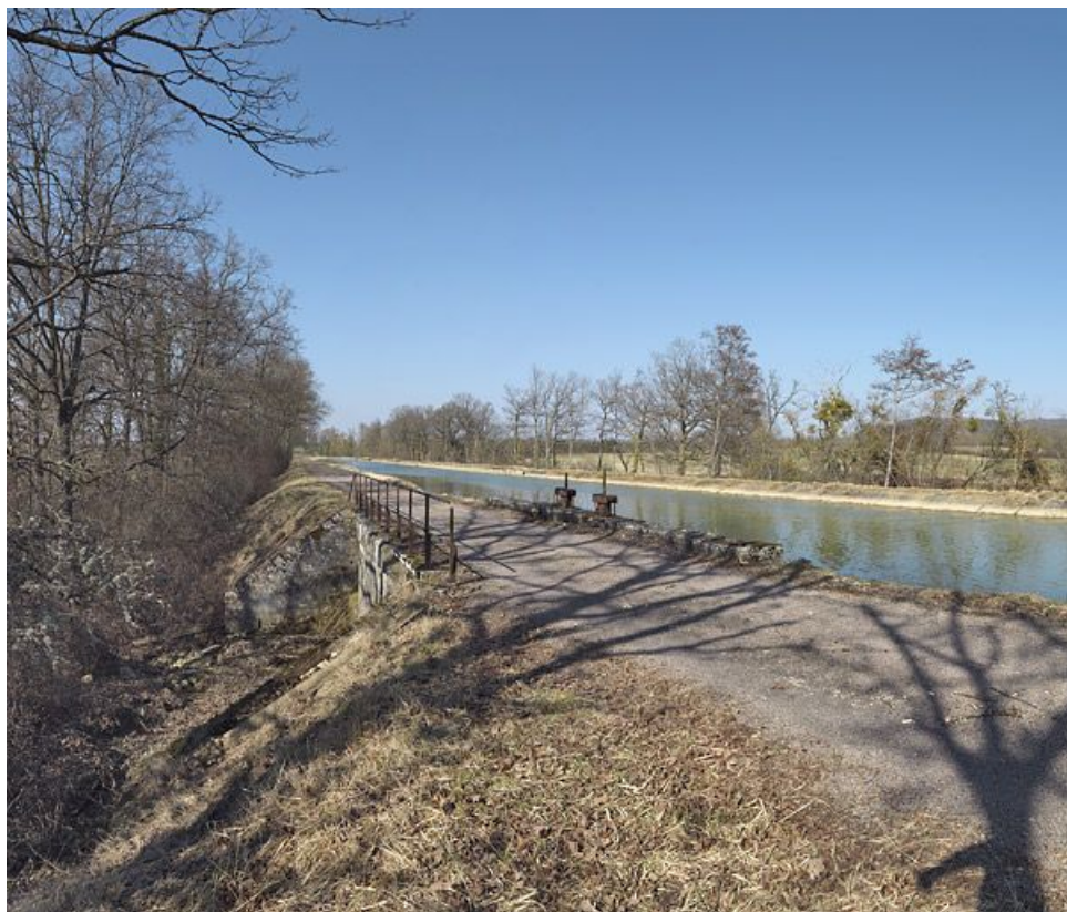
Vue d'ensemble de la sortie de l'aqueduc de Beurisot avec ses deux vannes, rive gauche.
