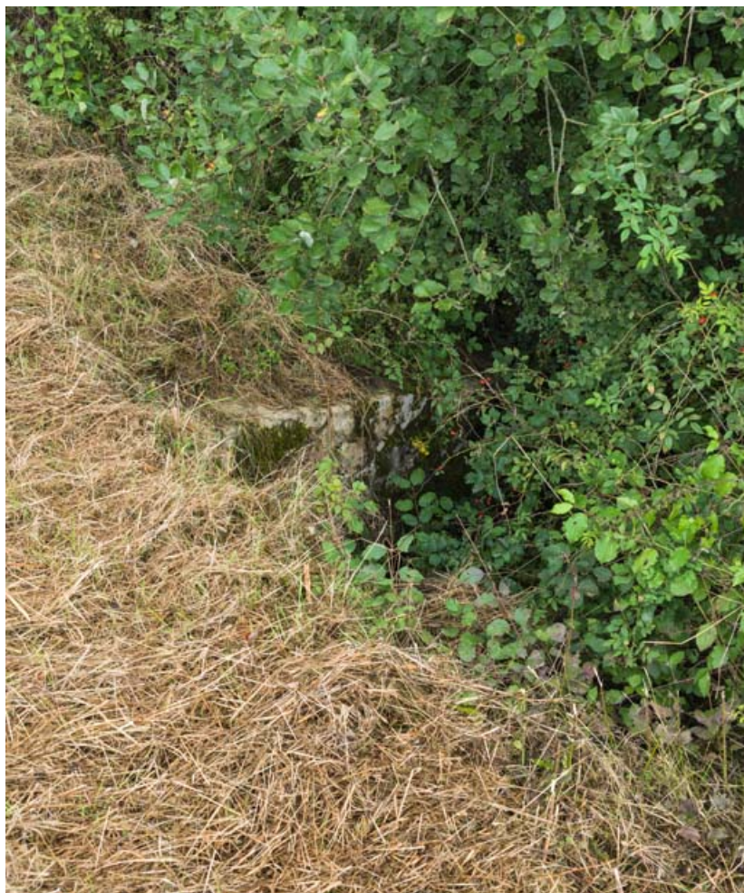
Vue de l'aqueduc situé en amont du port du Pont-Royal.
