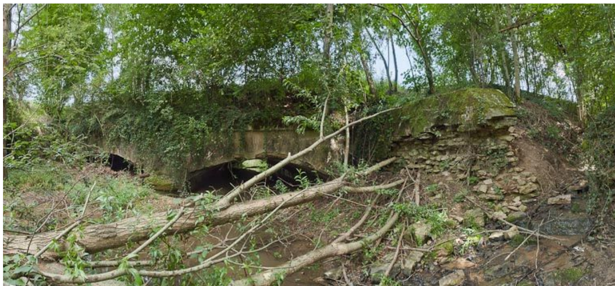
Vue des deux arches de l'aqueduc.
