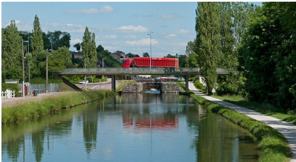
Le pont avec le site d'écluse en arrière-plan.
