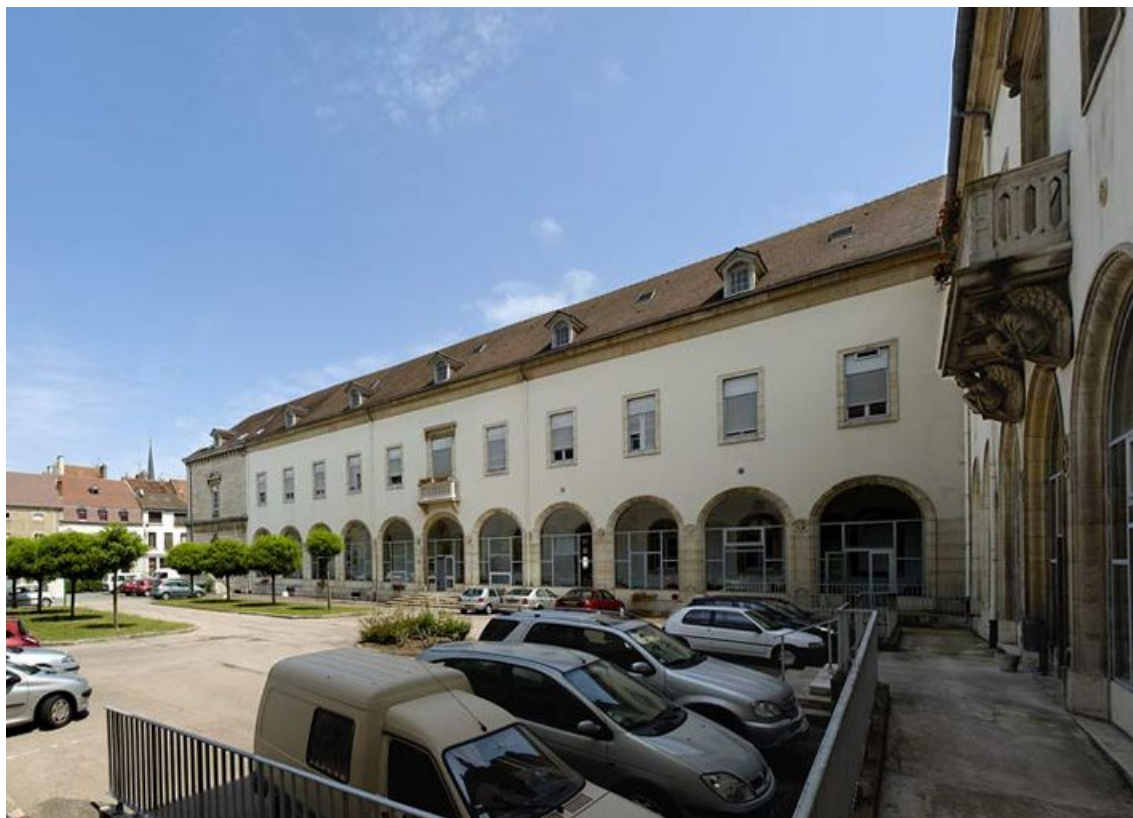
Aile gauche, élévation sur la cour d'honneur. 21, Auxonne rue Colonel-Denfert
