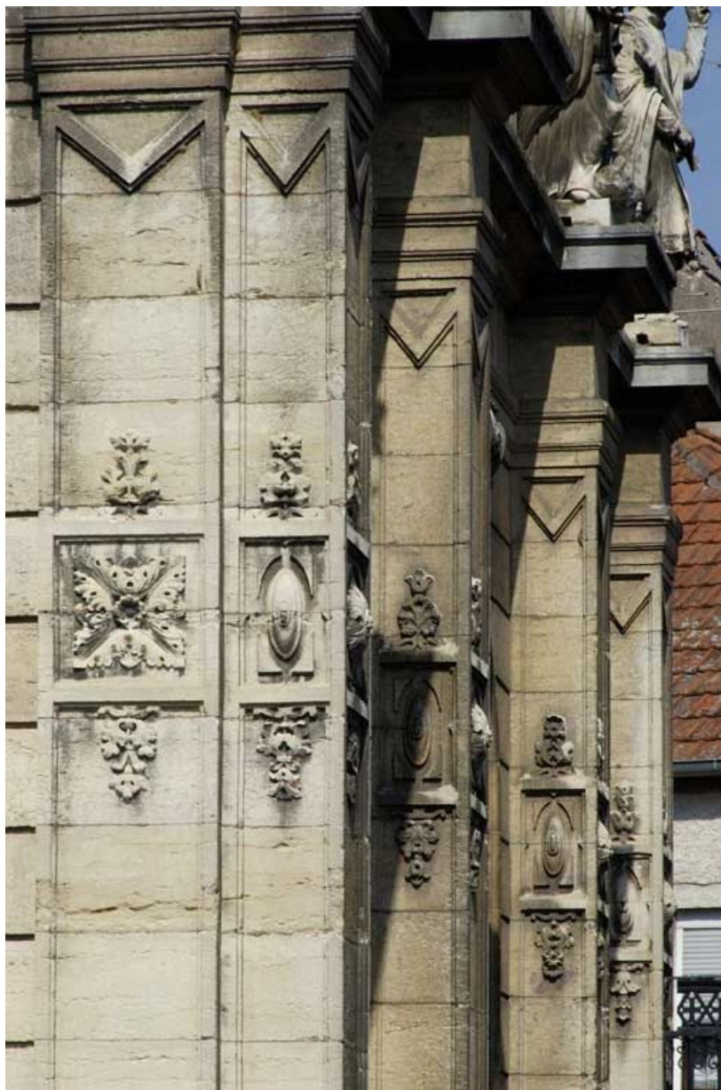
Mur de croupe de l'aile droite, détail.
