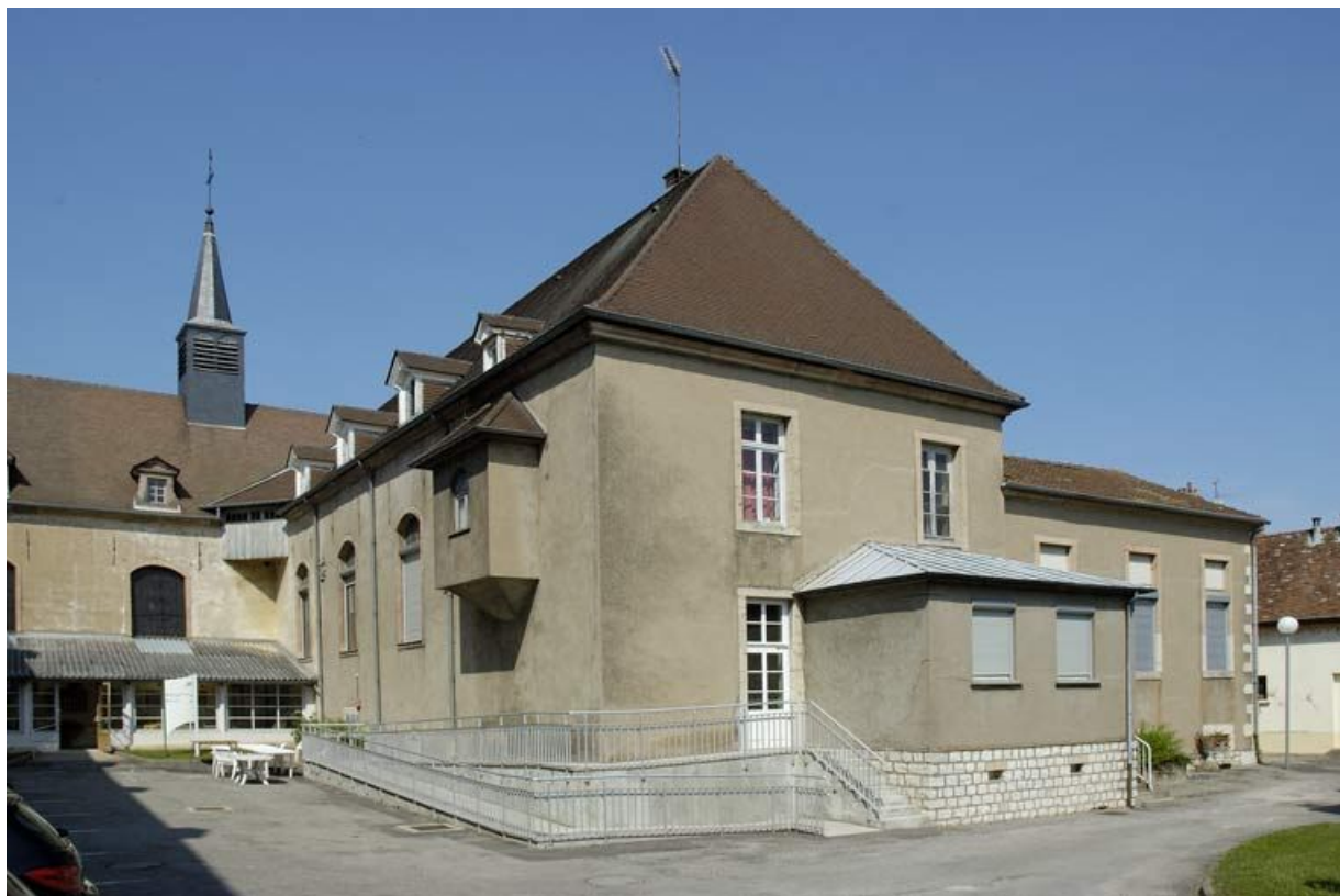
Élévation sud-est de la chapelle et corps de bâtiment en retour d'équerre.
