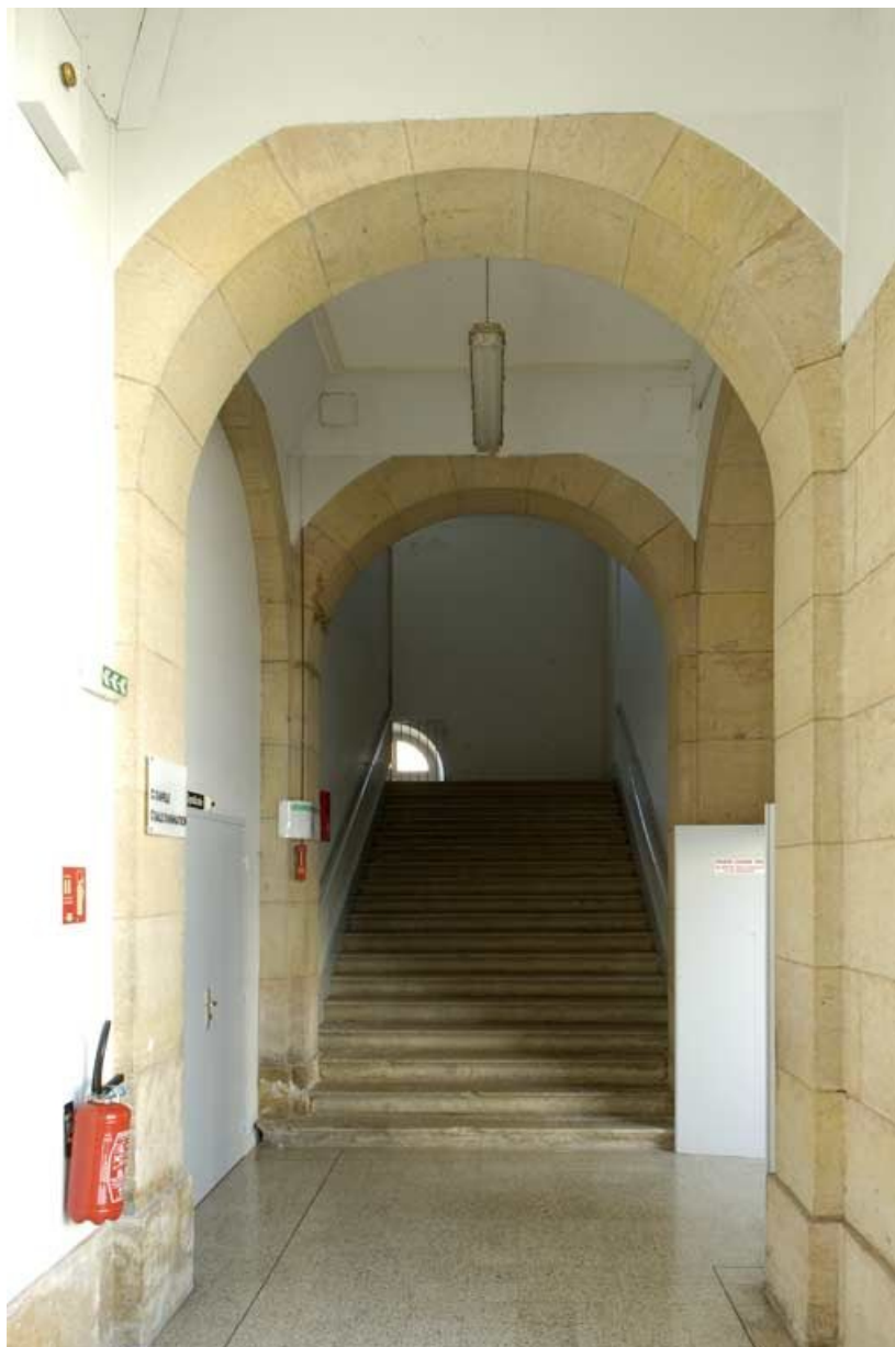
Escalier de la galerie donnant sur la cour antérieure.
