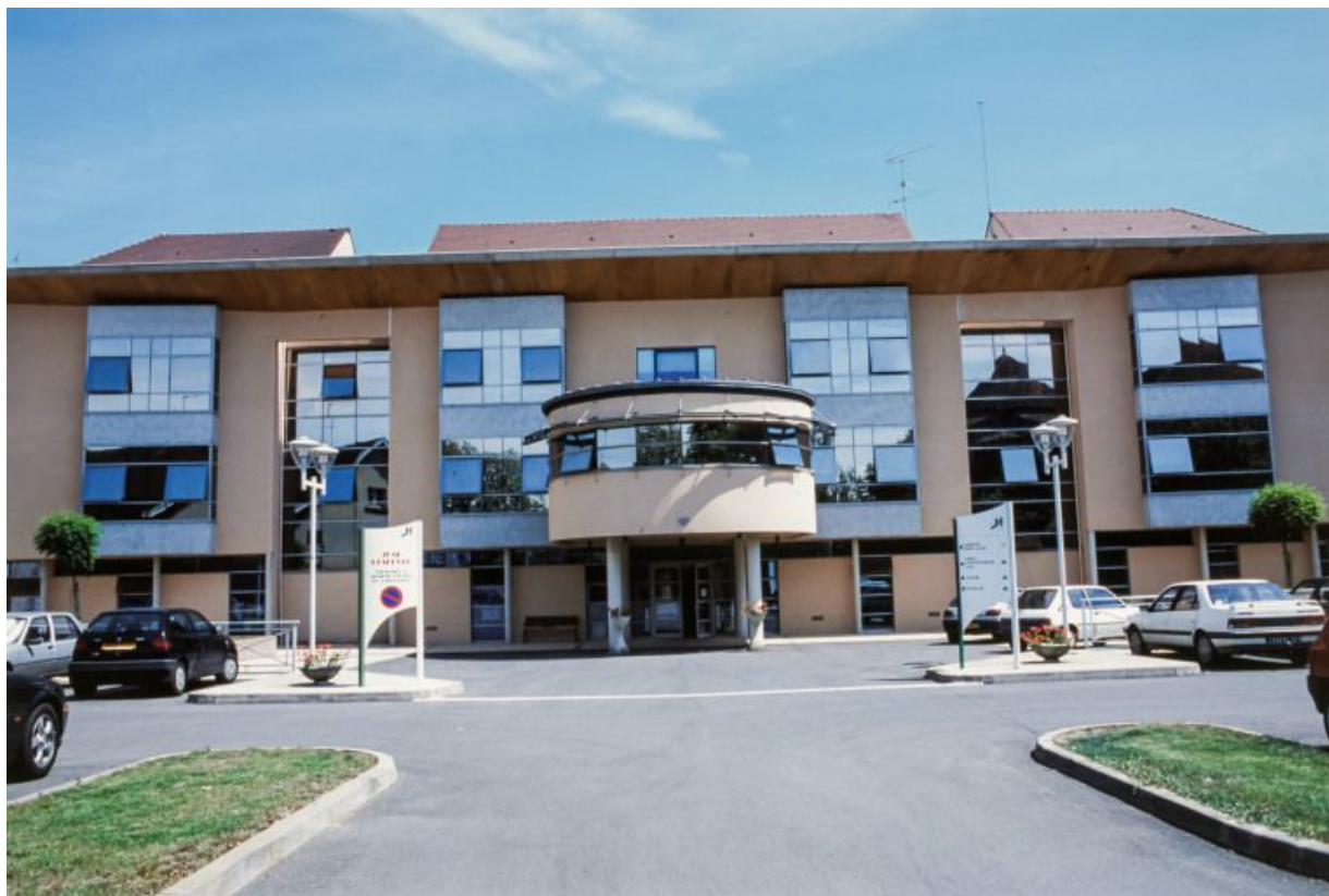
Bâtiments de la seconde moitié du 20e siècle.
