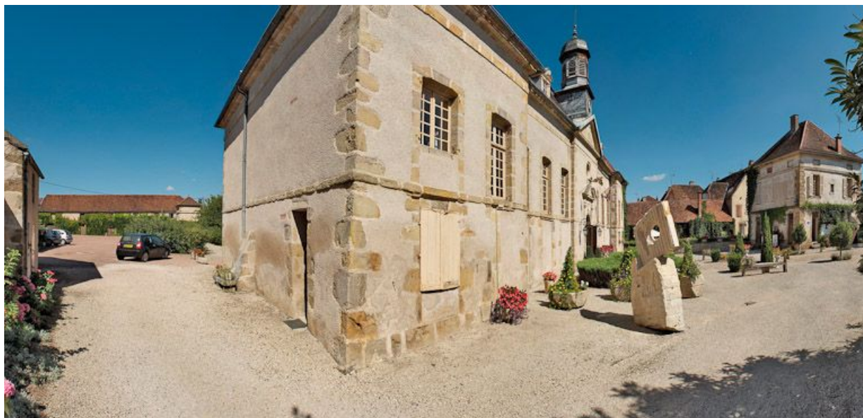
Vue d'ensemble des bâtiments depuis le sud.
