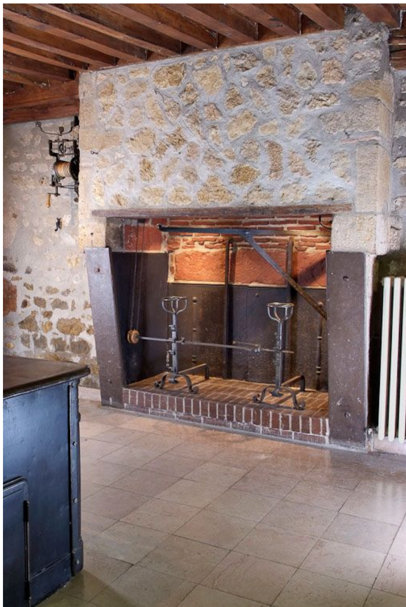
Cheminée de la cuisine et son tourne-broche.
