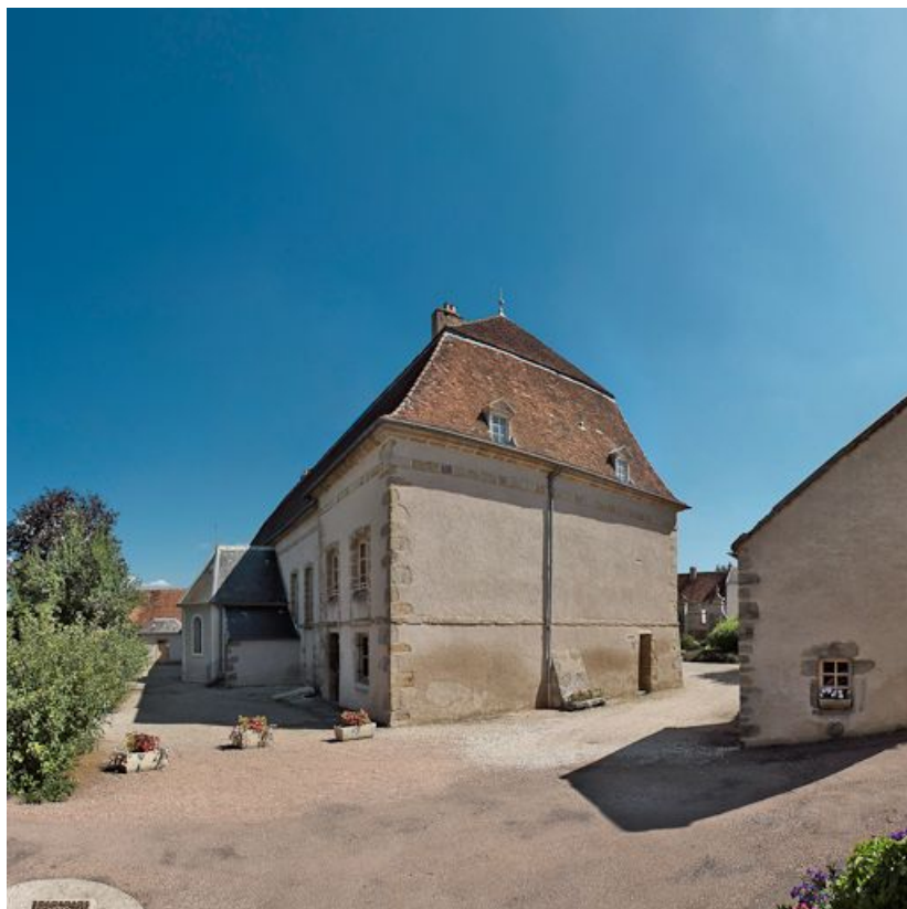
Façades postérieure et gauche (sud) du bâtiment principal.
