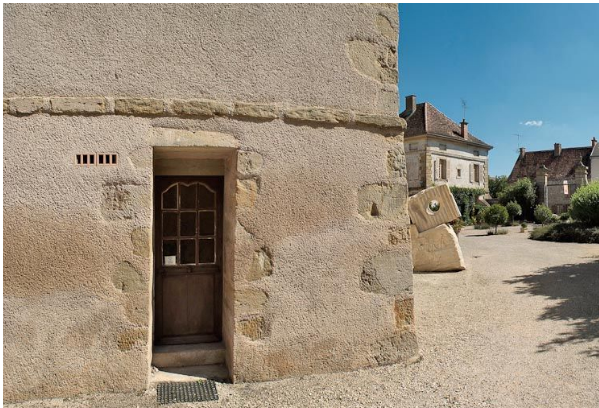
Porte latérale sud du bâtiment principal.
