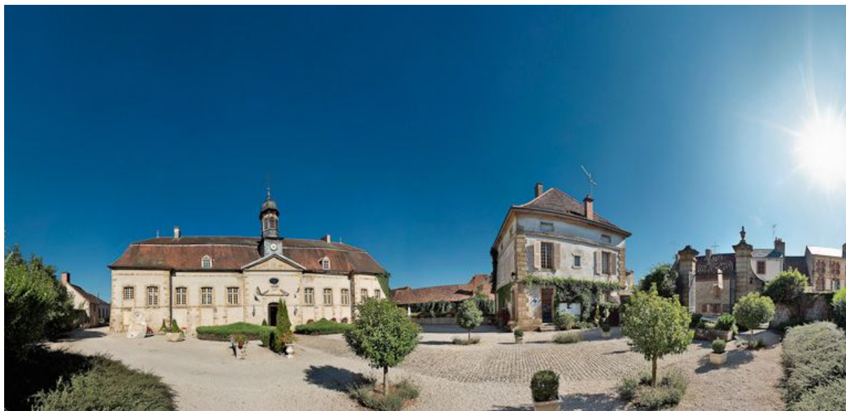
Vue d'ensemble depuis l'angle sud-est de la cour.
