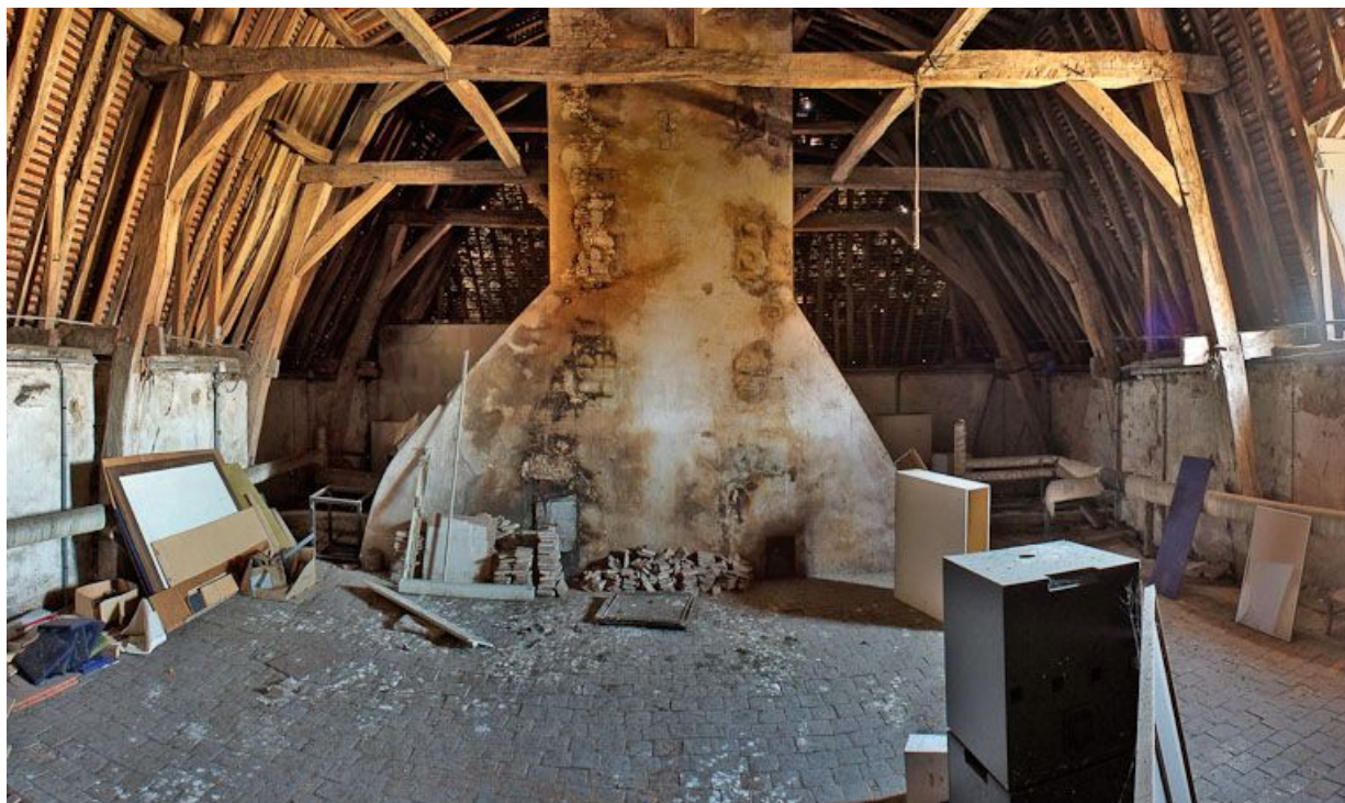
Comble du bâtiment principal, partie nord.
