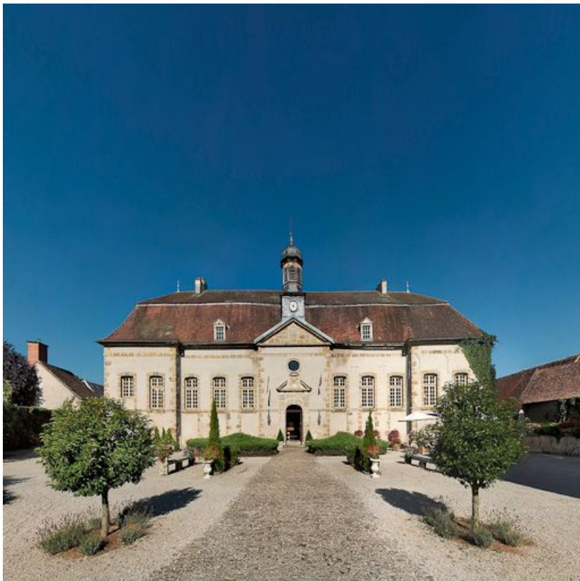
Façade antérieure du bâtiment principal.
