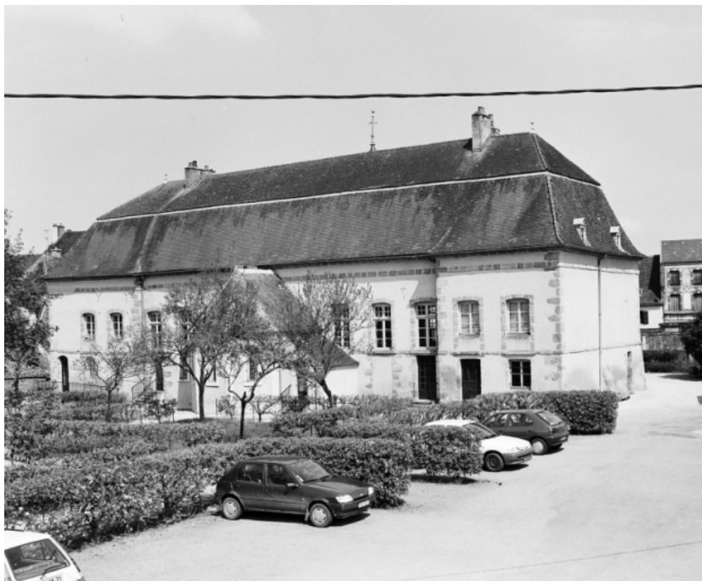
Façade postérieure en 2001.
