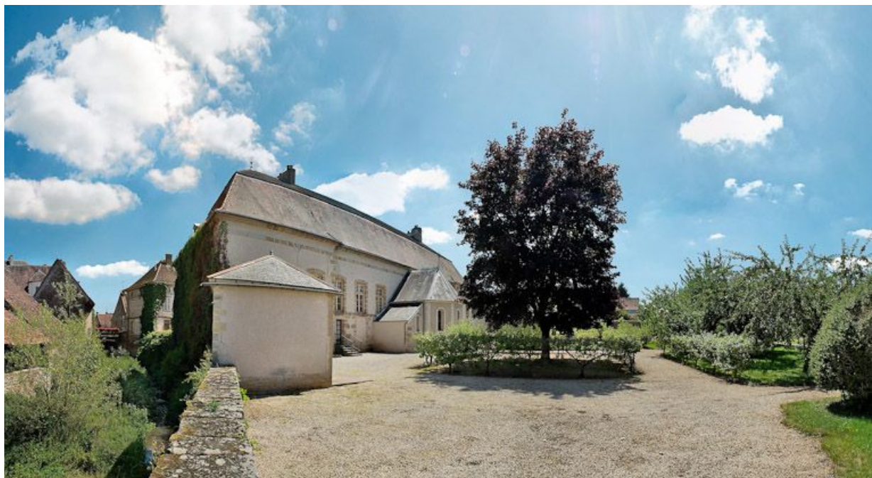
Façades postérieure et droite (nord) du bâtiment principal.
