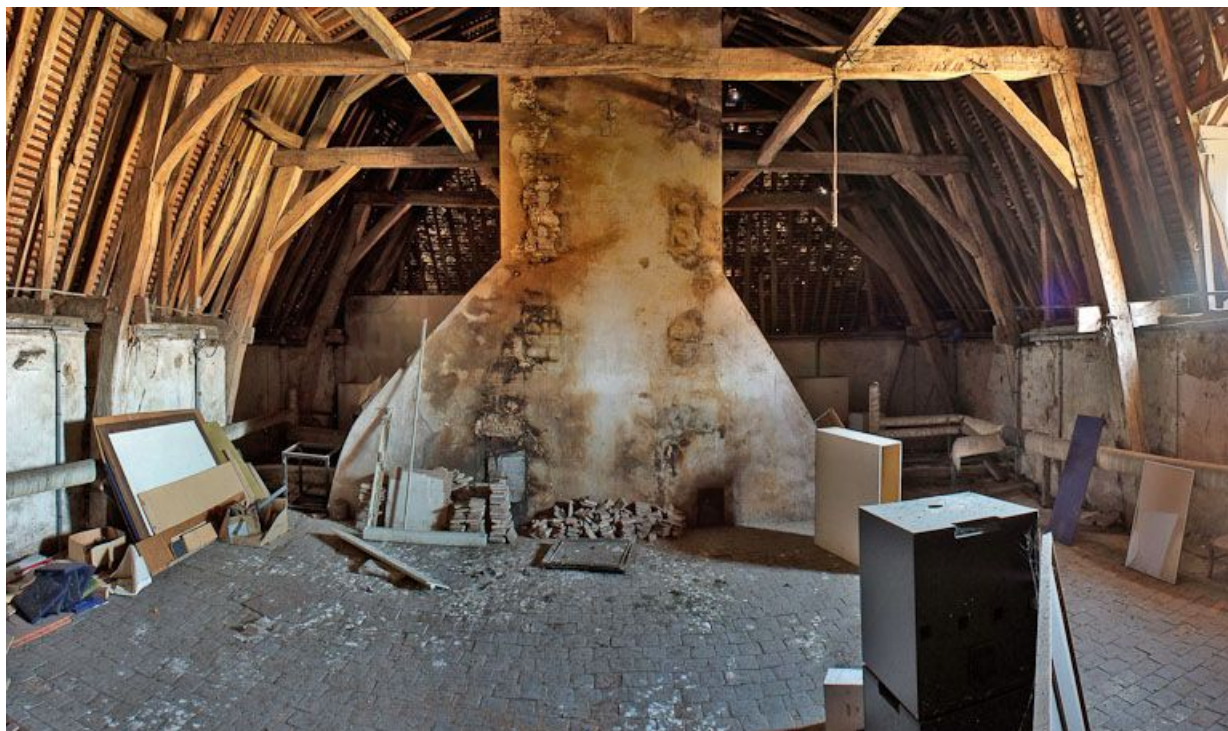
Comble du bâtiment principal, partie nord.
