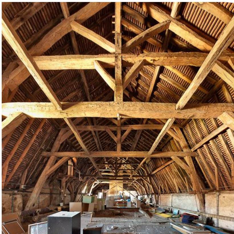
Vue d'ensemble du comble du bâtiment principal.
