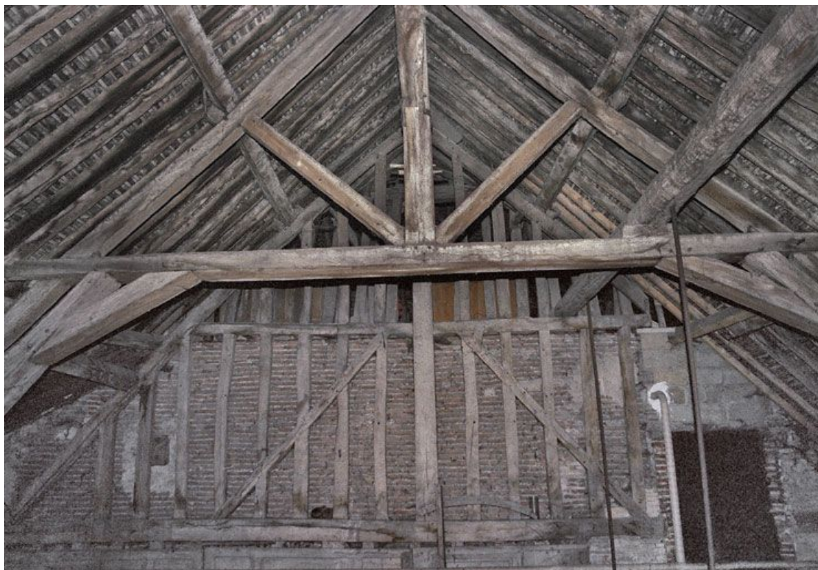
Bâtiment de plan en U : comble du corps principal, avant travaux. 21, Saint-Jean-de-Losne place d' Armes
