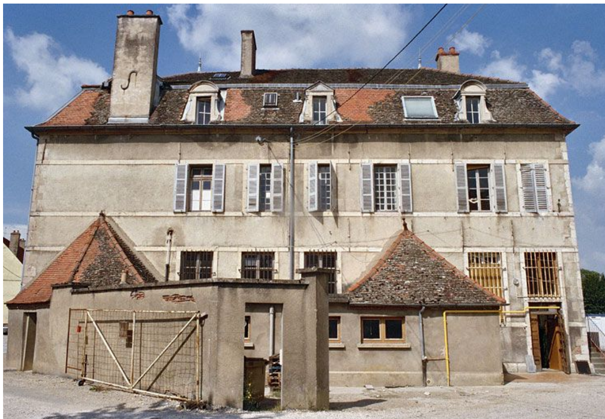
Aile est du bâtiment en U : façade est de l'aile est. 21, Saint-Jean-de-Losne place d' Armes
