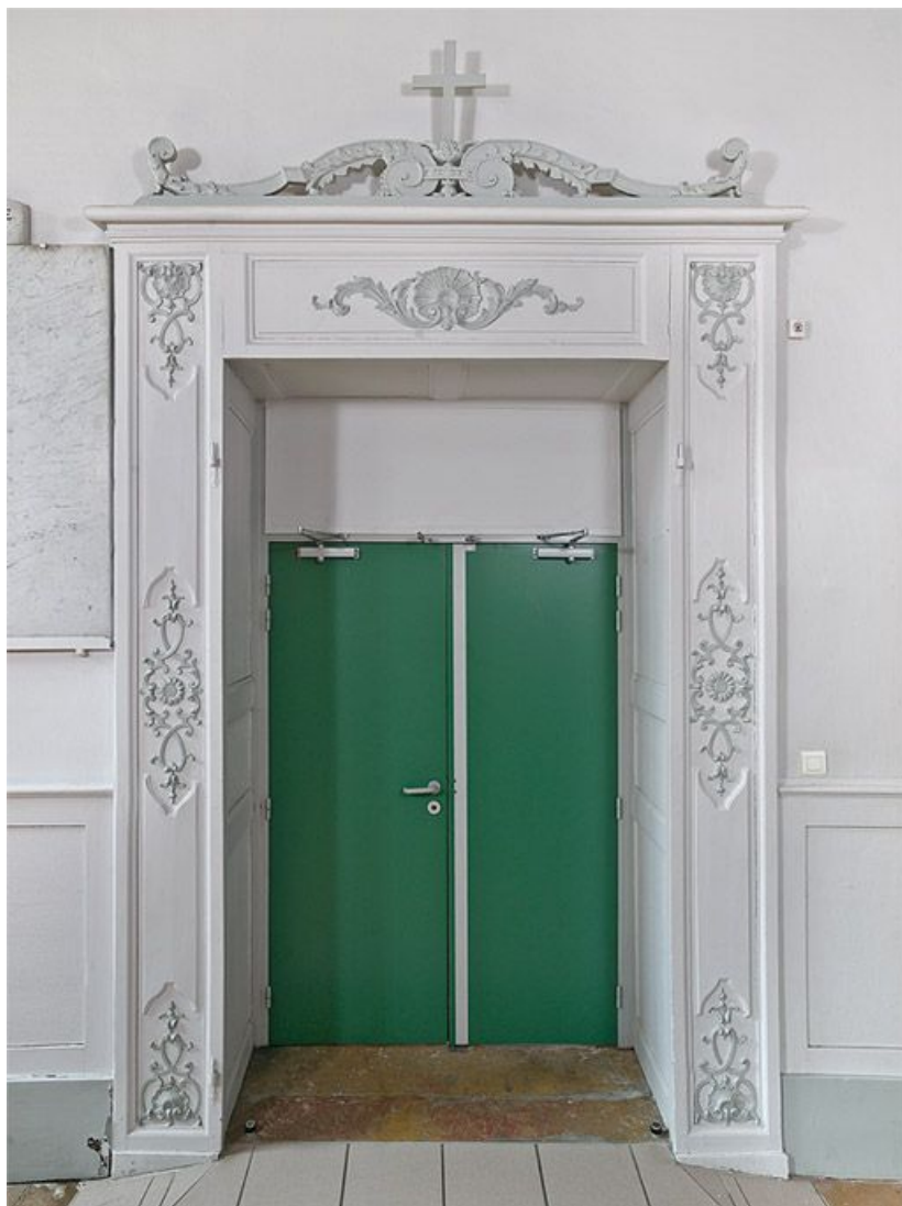
Porte d'entrée de l'ancienne salle des femmes.
