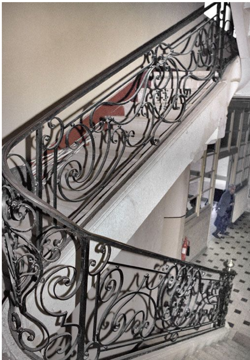
Immeuble en retrait sur la rue, avant travaux : escalier tournant à retours. 21, Saint-Jean-de-Losne place d'Armes
