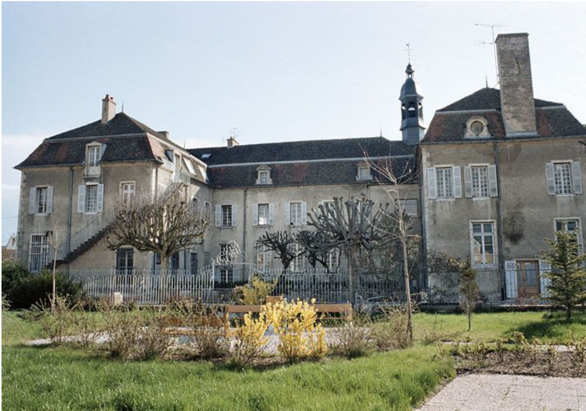
Bâtiment de plan en U : façade postérieure sur jardin, avant travaux. 21, Saint-Jean-de-Losne place d' Armes
