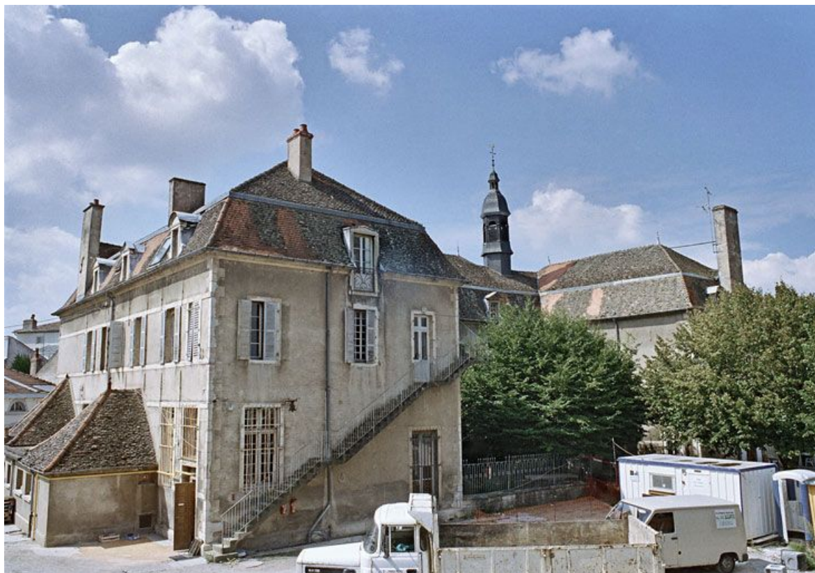
Bâtiment en U, vue prise de l'est.
