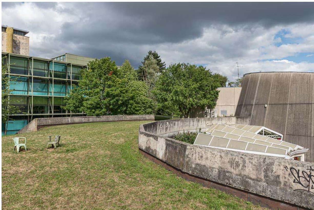
Aile semi-circulaire : toiture végétalisée.
