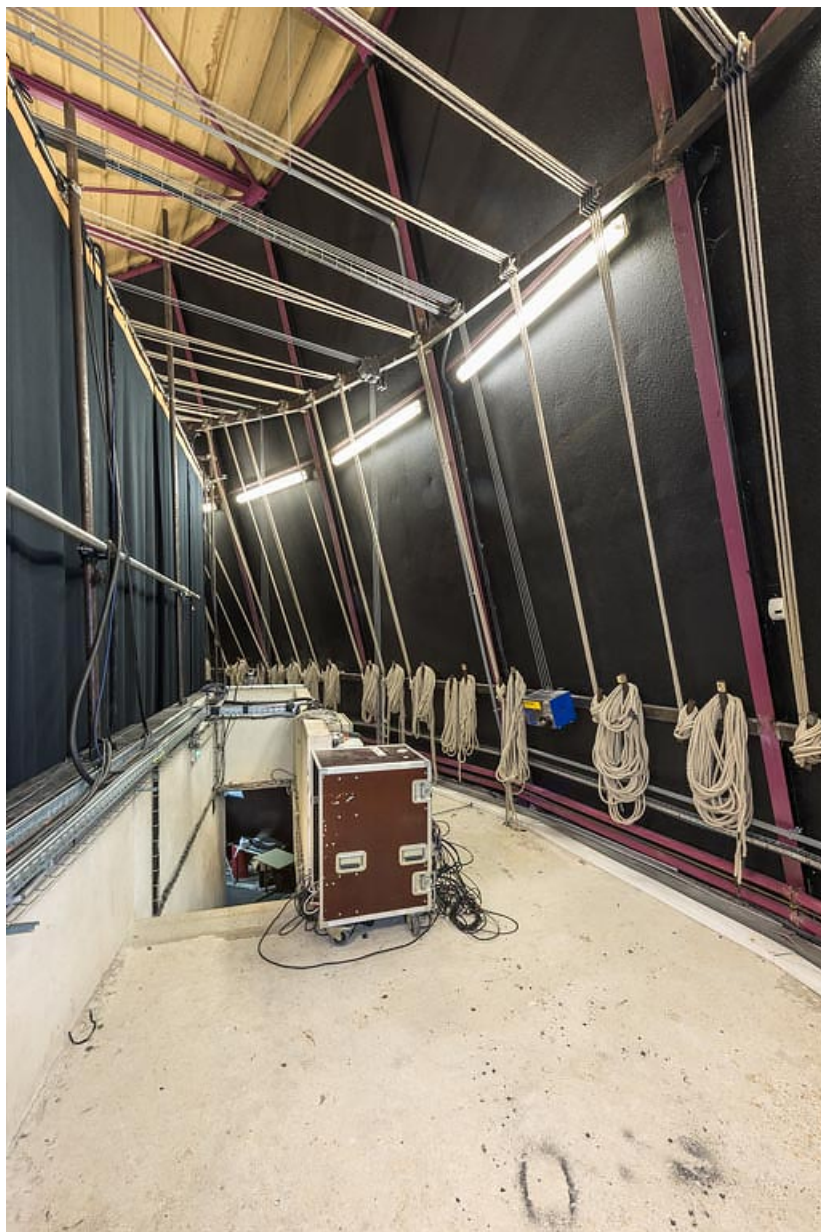
Salle : circulation latérale et charpente métallique.
