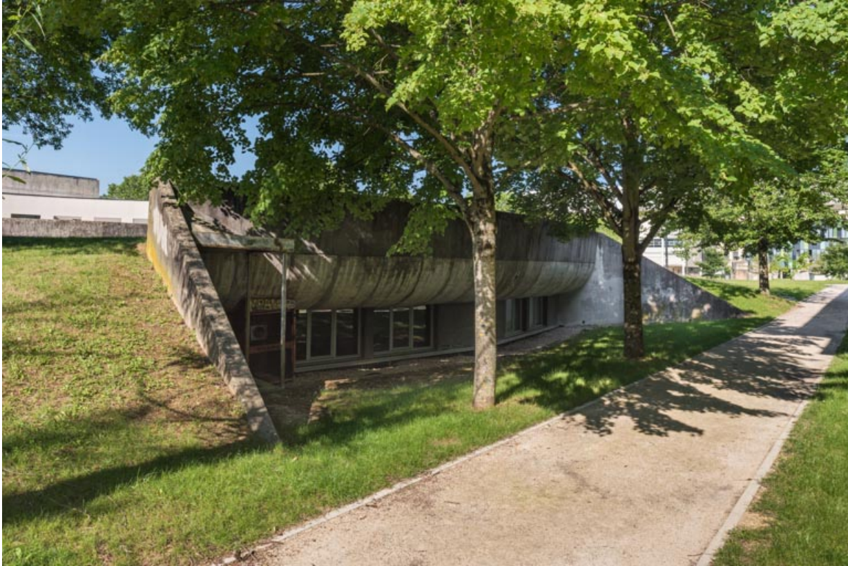
Aile semi-circulaire : fenêtre au nord.
