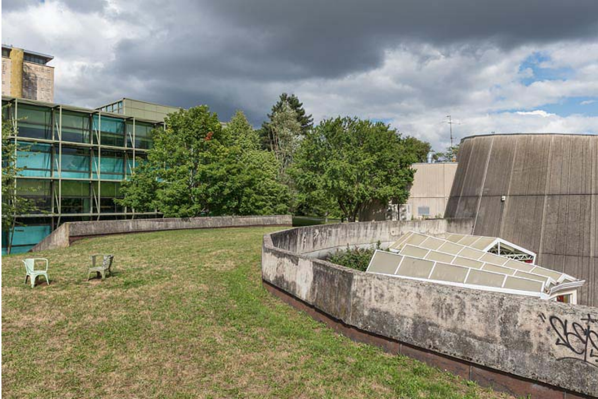
Aile semi-circulaire : toiture végétalisée.
