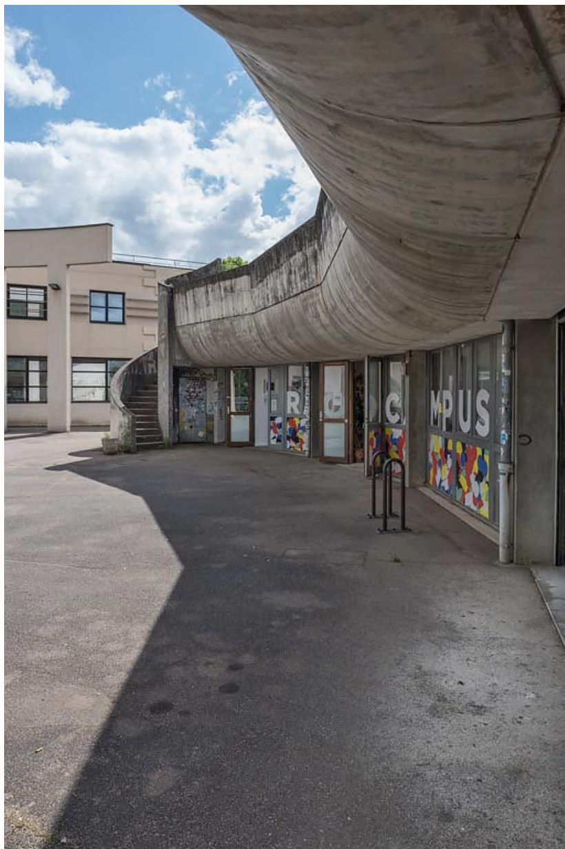
Aile semi-circulaire : toiture formant auvent côté cour.
