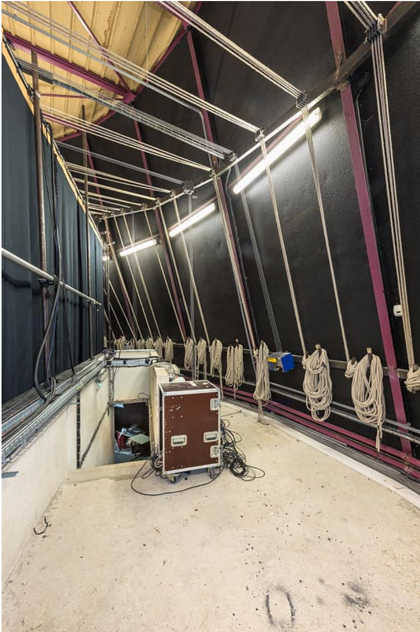
Salle : circulation latérale et charpente métallique.
