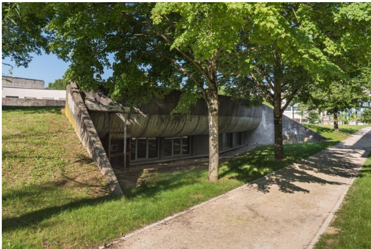
Aile semi-circulaire : fenêtre au nord.
