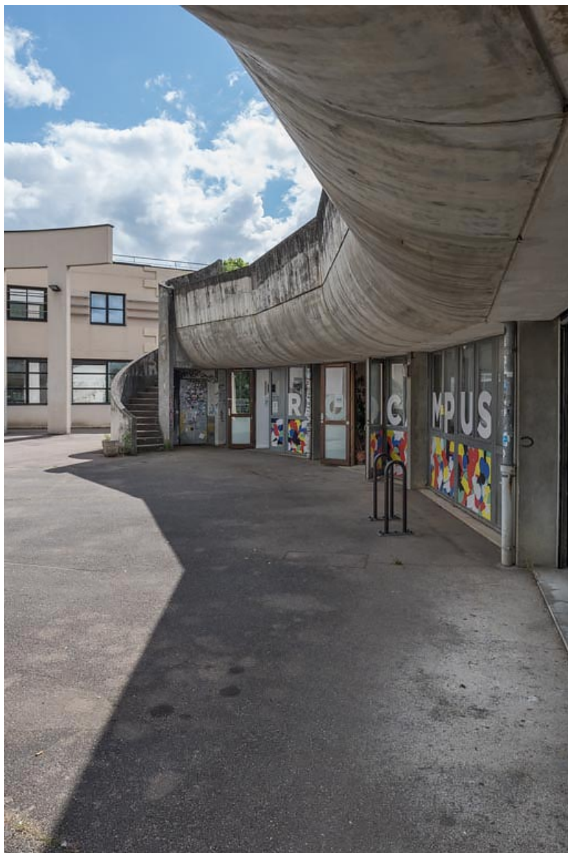
Aile semi-circulaire : toiture formant auvent côté cour.
