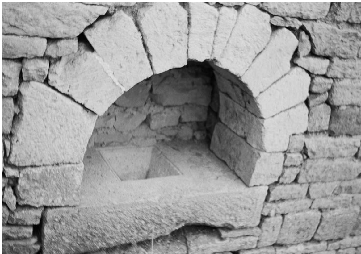
Lavabo extérieur du mur nord-est de la salle des malades.
