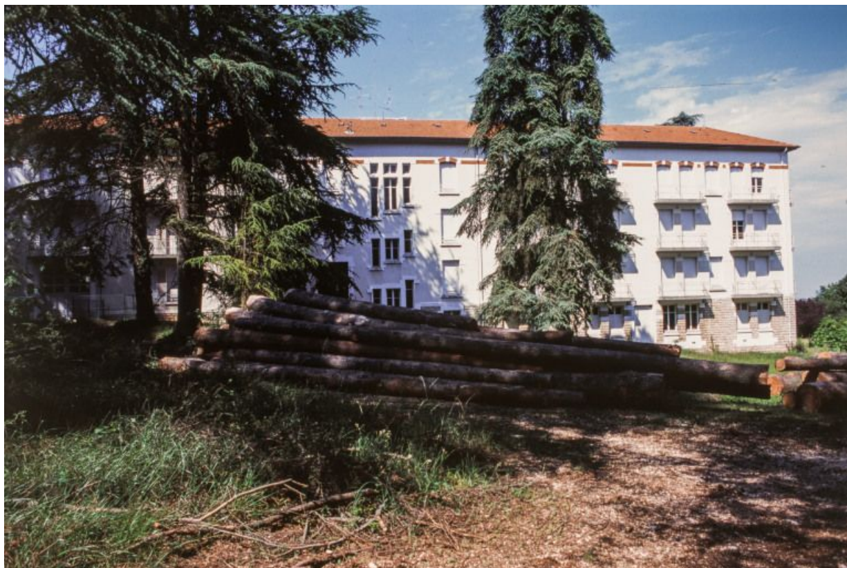
Vue extérieure d'une aile.
