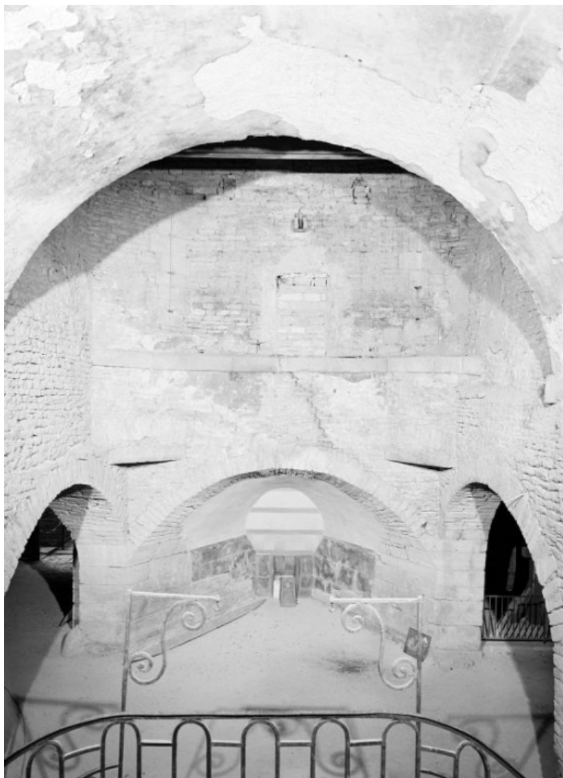
Haut fourneau, halle de coulée, vue prise de l'escalier d'honneur.
