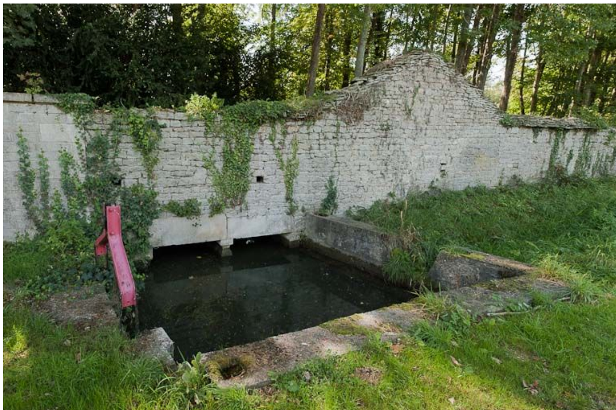
Vue du bassin et des vannes collectant les eaux du lavoir.
