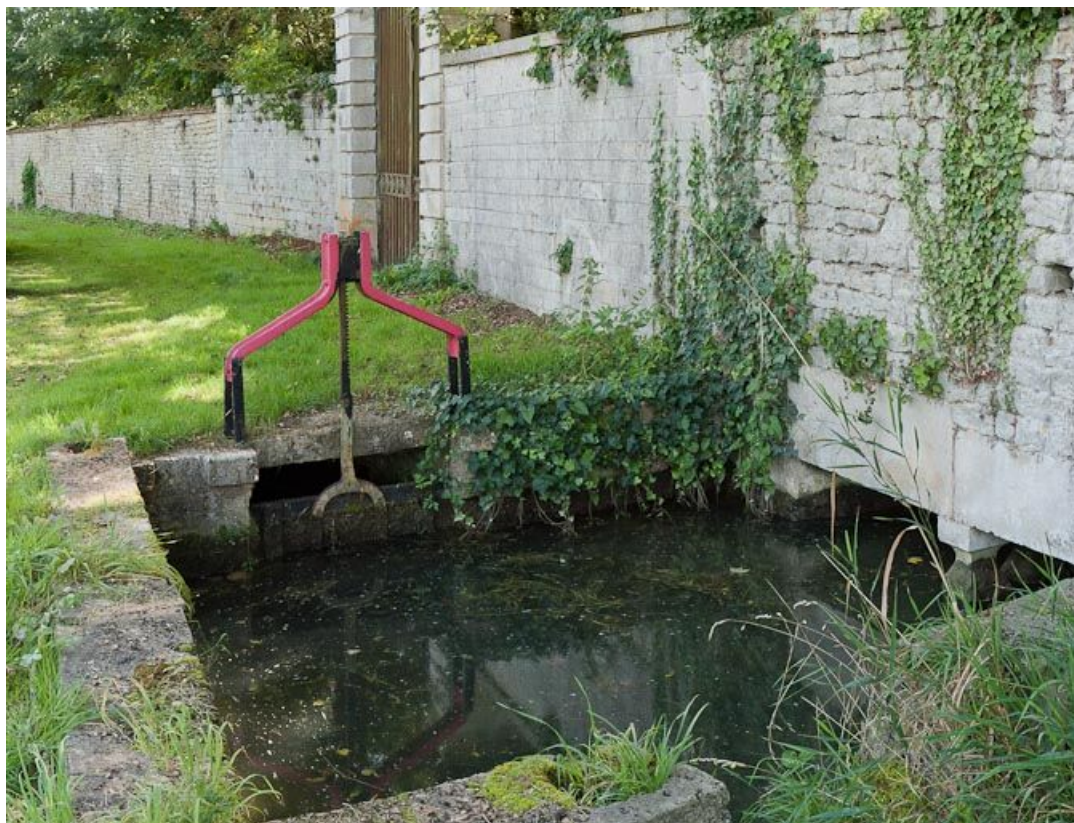
Vue du bassin et des vannes collectant les eaux du lavoir.
