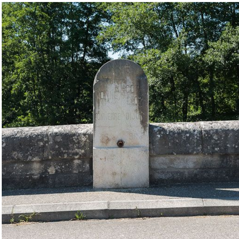
Borne de séparation entre les départements de l'Yonne et de la Côte-d'Or, sur le pont sur l'Armançon. 21, Rougemont, lieudit : bief 71 du versant Yonne
