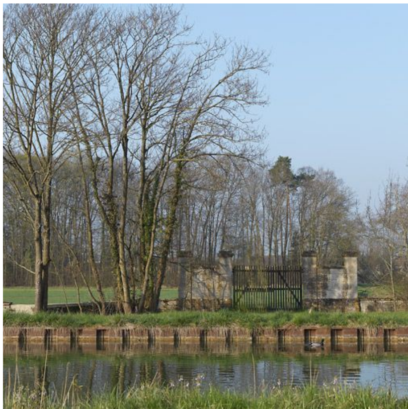
Portail du parc du château de Longecourt donnant sur le canal.
