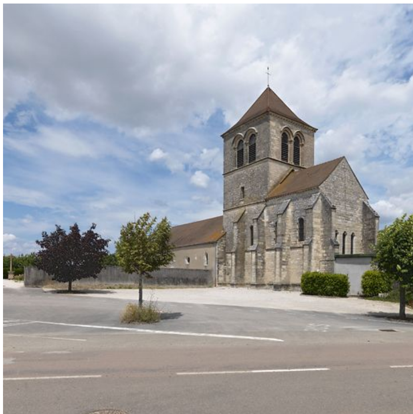
Eglise Saint-Pierre : vue d'ensemble.
