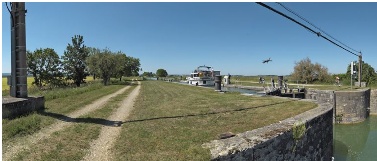
Le site d'écluse pris d'aval ; à gauche : les pistes de l'aéroport. La maison éclusière a été détruite. 21, Ouges, lieudit : bief 60 du versant Saône
