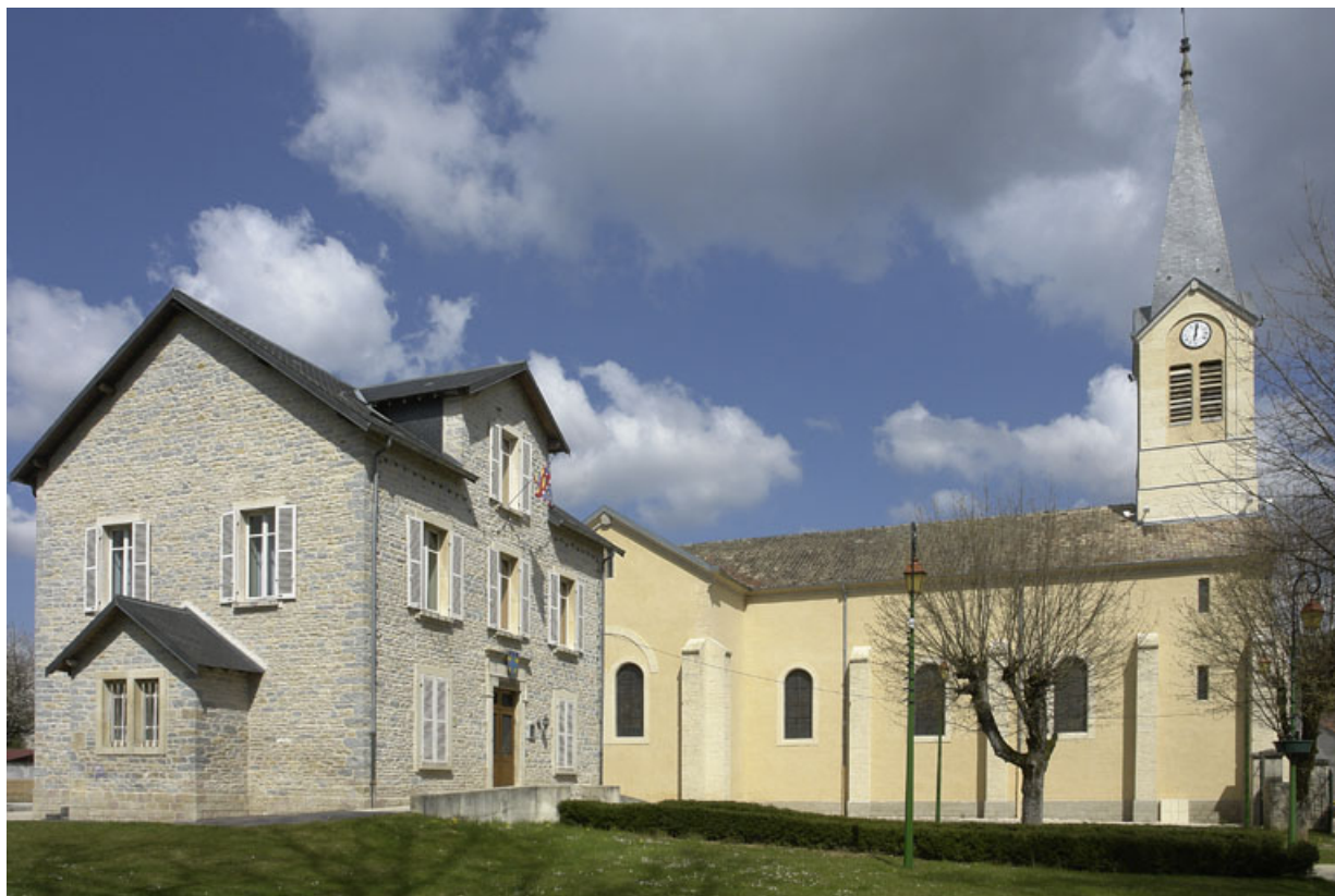
Élévation latérale gauche, vue d'ensemble avec au premier plan, l'ancien presbytère actuellement mairie.
