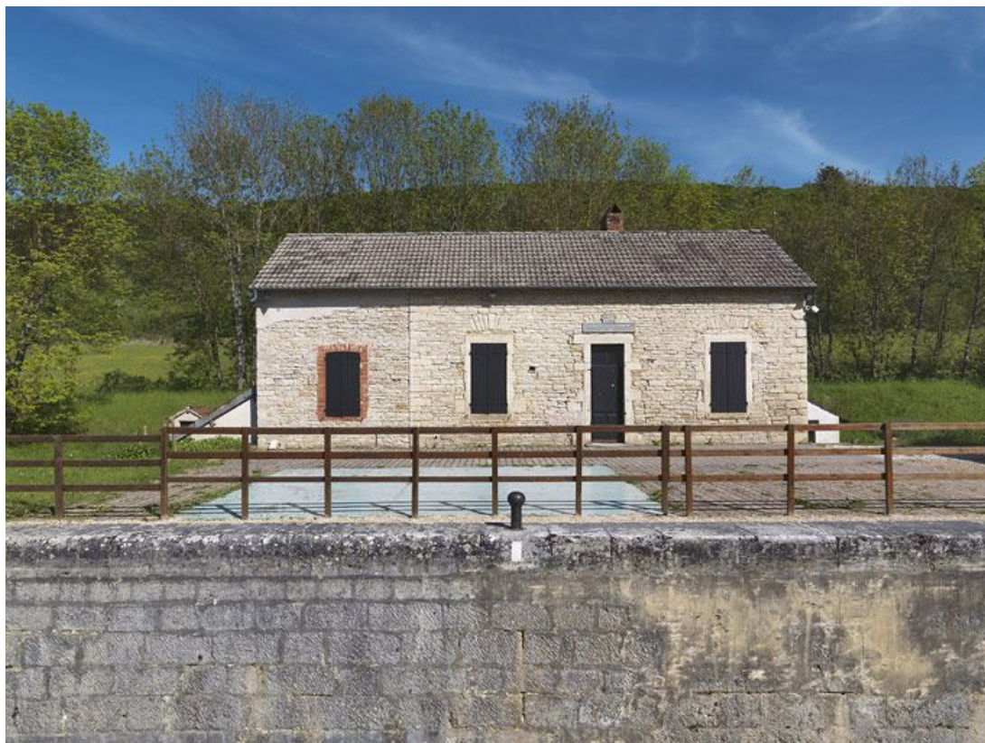
Site d'écluse : maison éclusière vue de face.
