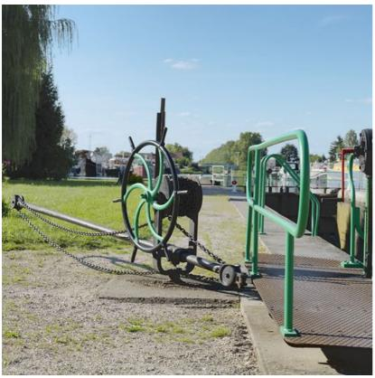
Détail du mécanisme des portes du sas.
