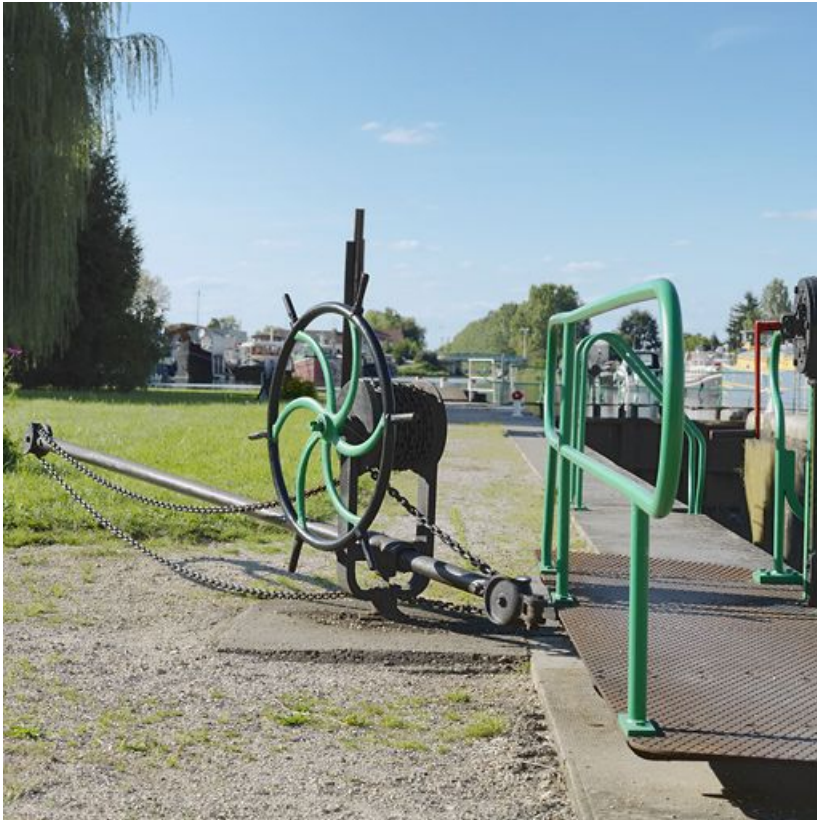
Détail du mécanisme des portes du sas.
