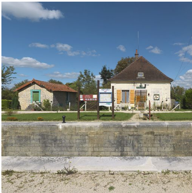
Vue de face de la maison éclusière et de ses annexes.
