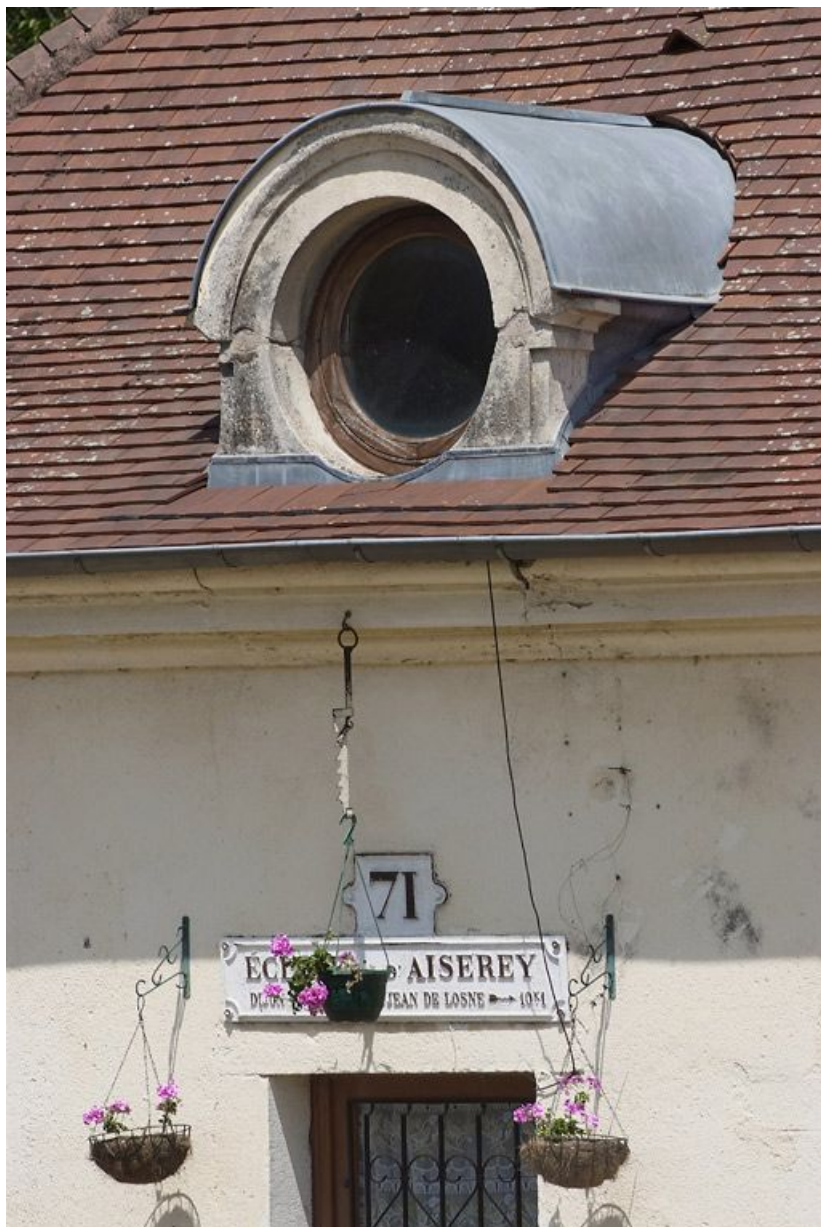
Détail de la lucarne en façade de la maison éclusière.
