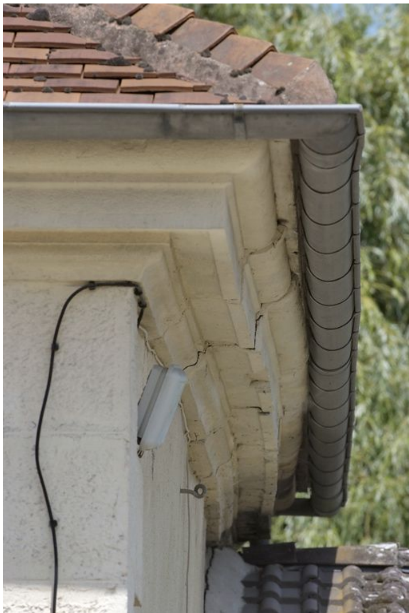
Détail de maçonnerie : la corniche en pierre de taille.
