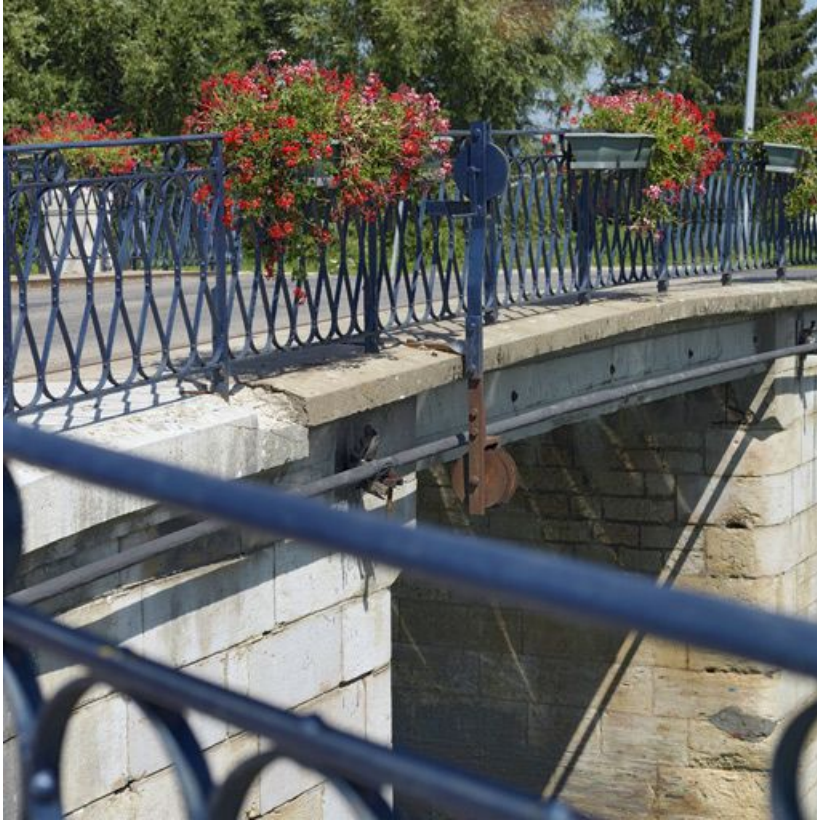
Détail de la poulie et du garde-corps.
