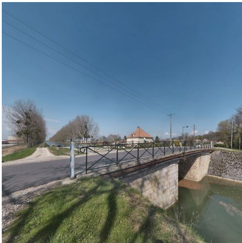
Vue d'ensemble, prise d'aval : remarquez le garde-corps.
