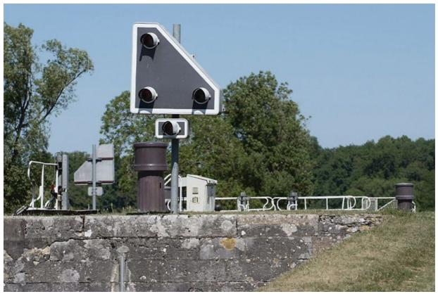
Détail du système d'automatisation de l'écluse : les feux de signalisation.
