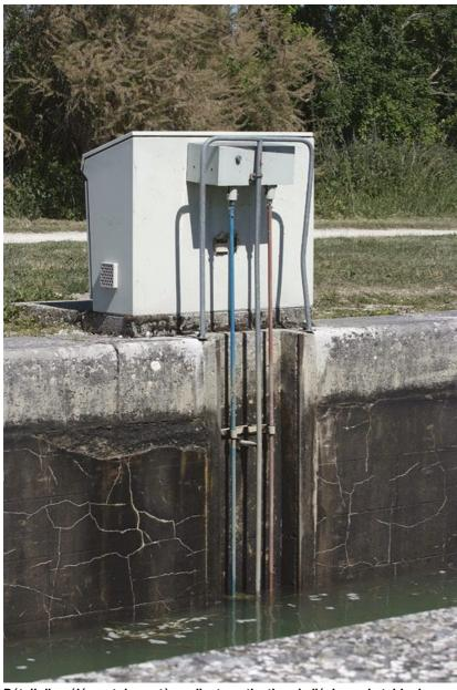
Détail d'un élément du système d'automatisation de l'écluse : la table de commande placée sur le bord du sas. 21, Ouges, lieudit : bief 63 du versant Saône
