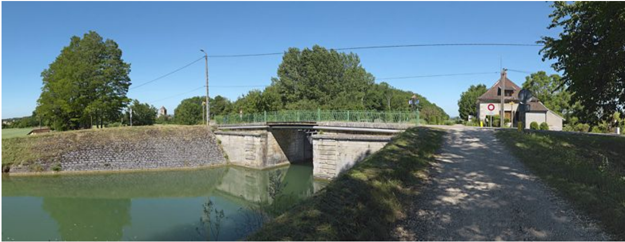
Le pont vu d'aval. Son rehaussement se lit nettement dans le décrochement de maçonnerie des piles.
