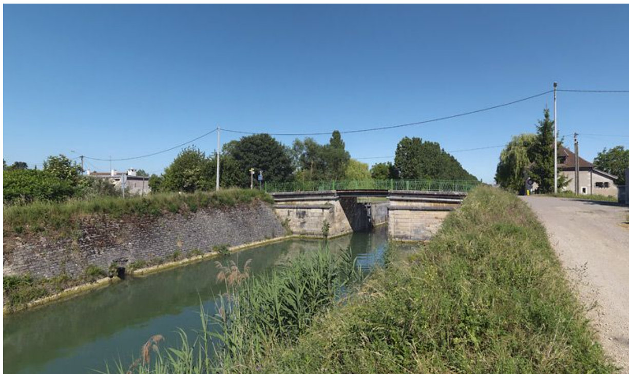
Pont vu d'aval. La maison éclusière est visible à droite.
