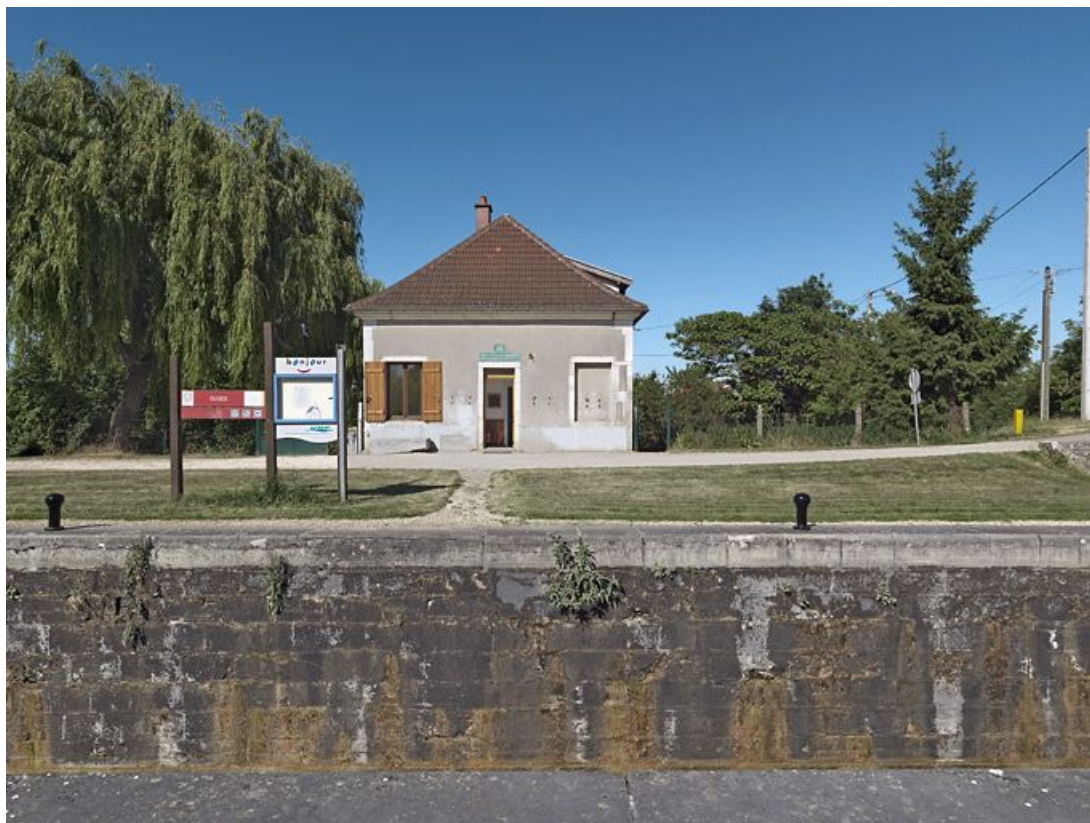
Maison éclusière de face : les ouvertures sont conformes au modèle de cette série.
