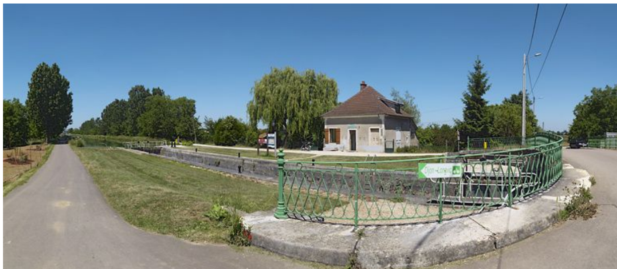
Site vu d'aval, avec garde-corps du pont au premier plan.
